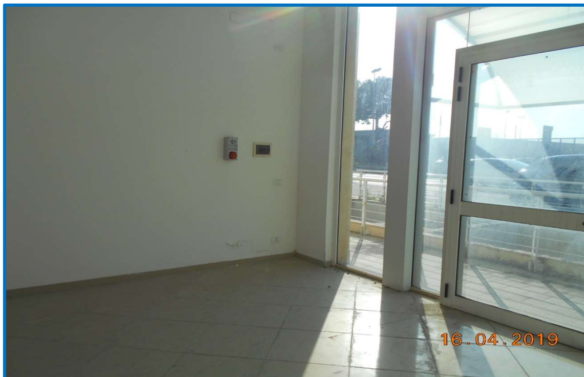
FOTO N.6: interni piano terra immobile in sub 15 – lotto n.1
