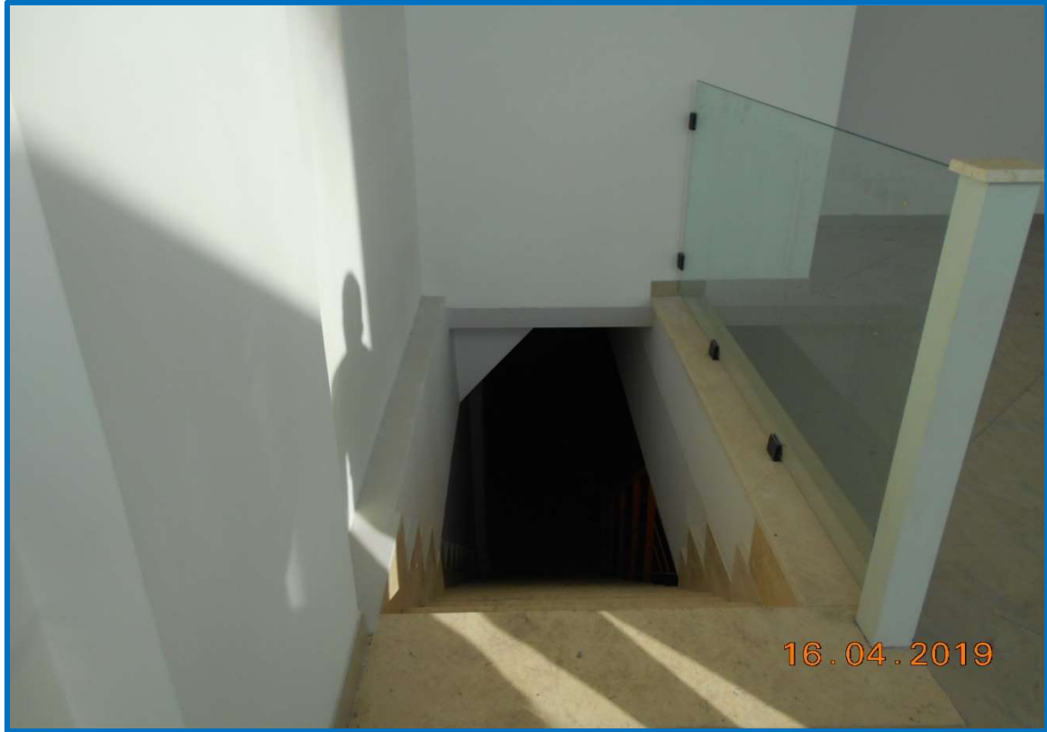
FOTO N.7: rampa di collegamento piano terra/piano S1 immobile in sub 15 – lotto n.1.
