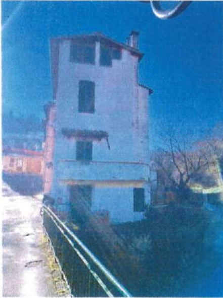
Fabbricato e fosso Ponterosso
