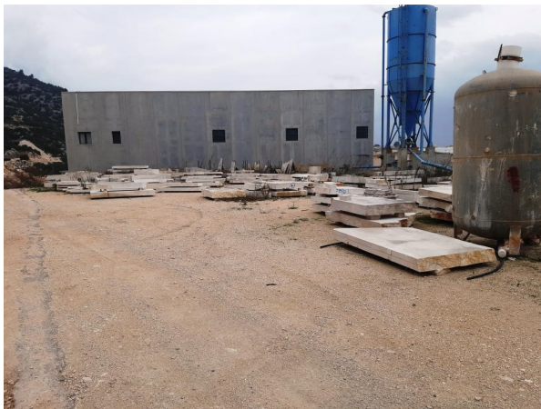
Immagine n.10 - Piazzale capannone
