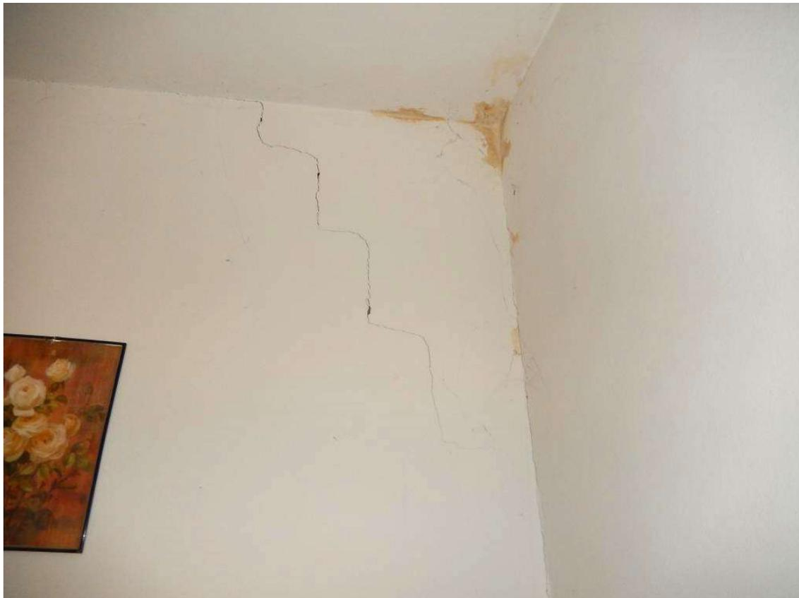
**PARTICOLARE INFILTRAZIONI DA COPERTO E FESSURAZIONI DA SISMA 2012**
