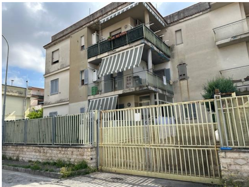
Foto 1: vista del fabbricato condominiale da viale Della Repubblica
