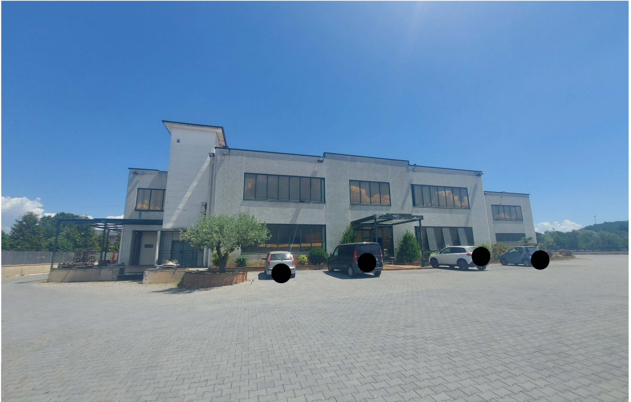
Foto 1 – fronte su strada
