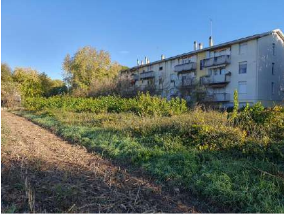
FOTO 3 : vista ovest mappale 1031
