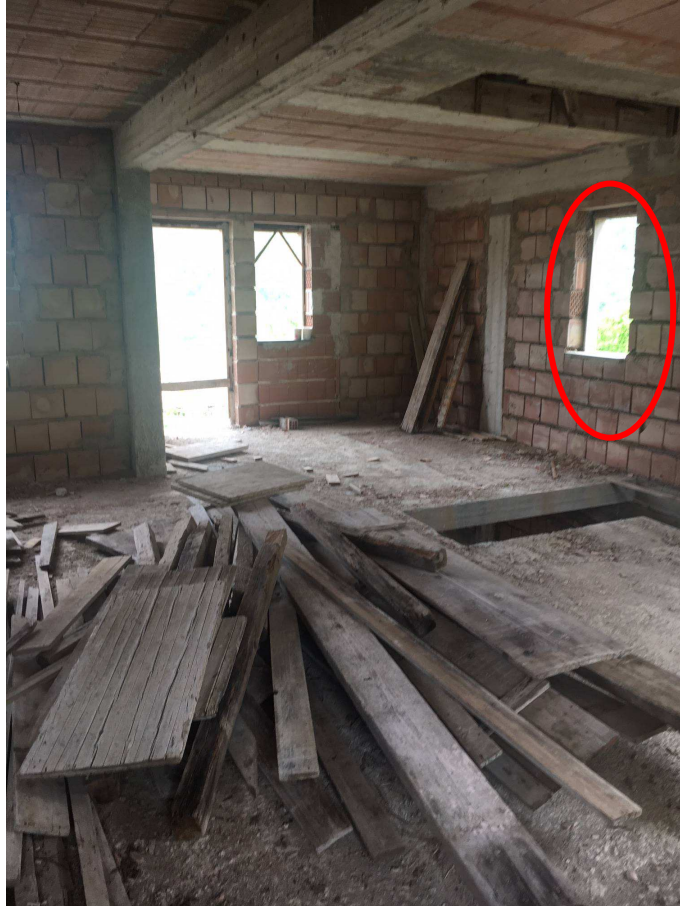
Figura 4-11 Finestra sul lato Sud – vista dall'interno
