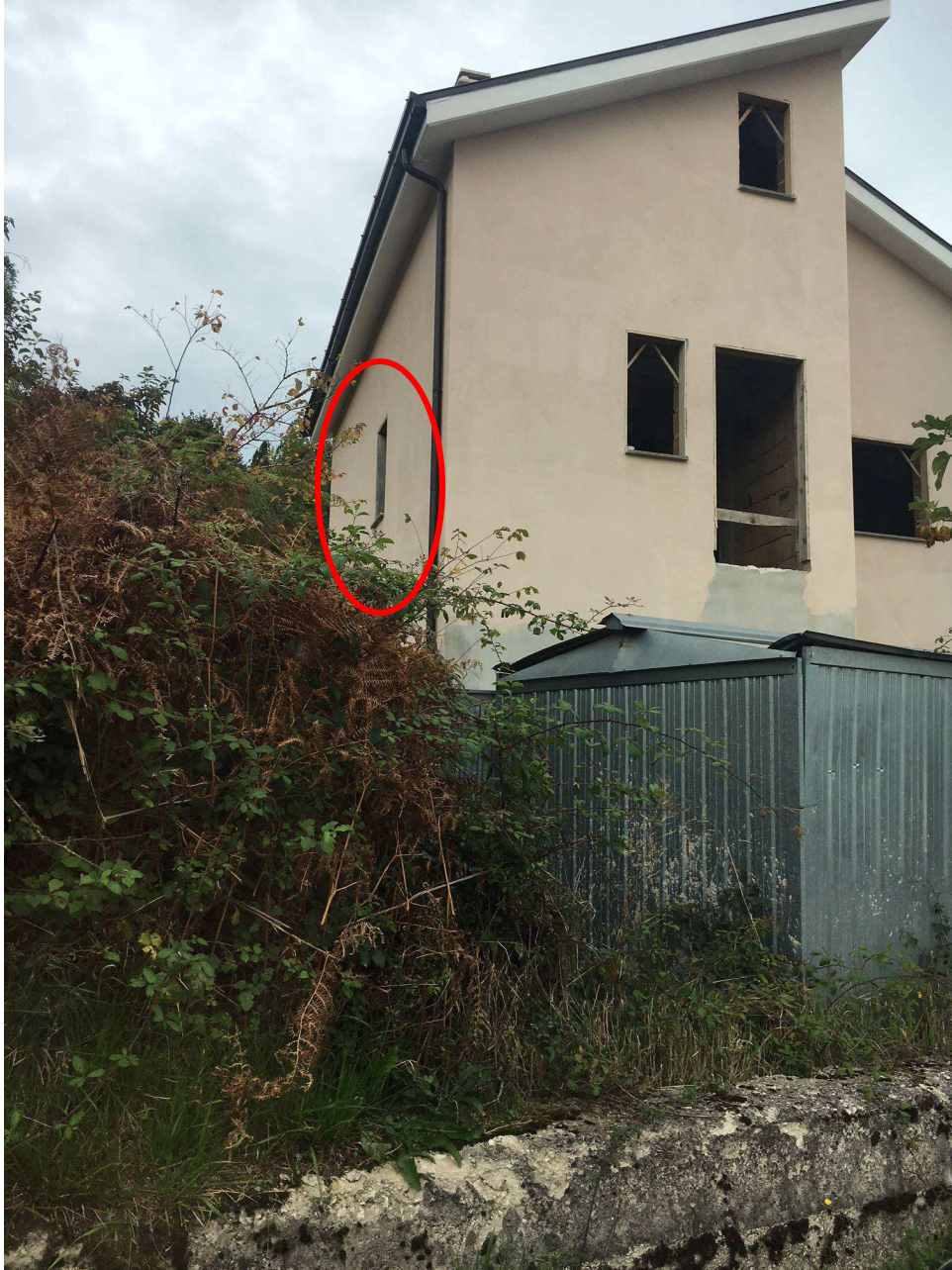
Figura 4-12 Finestra sul lato Sud – vista dall'esterno
