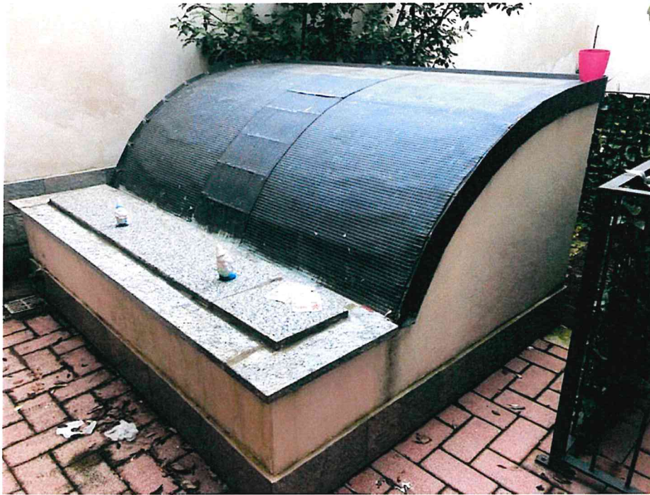
Dettaglio lucernario nel giardino di pertinenza
