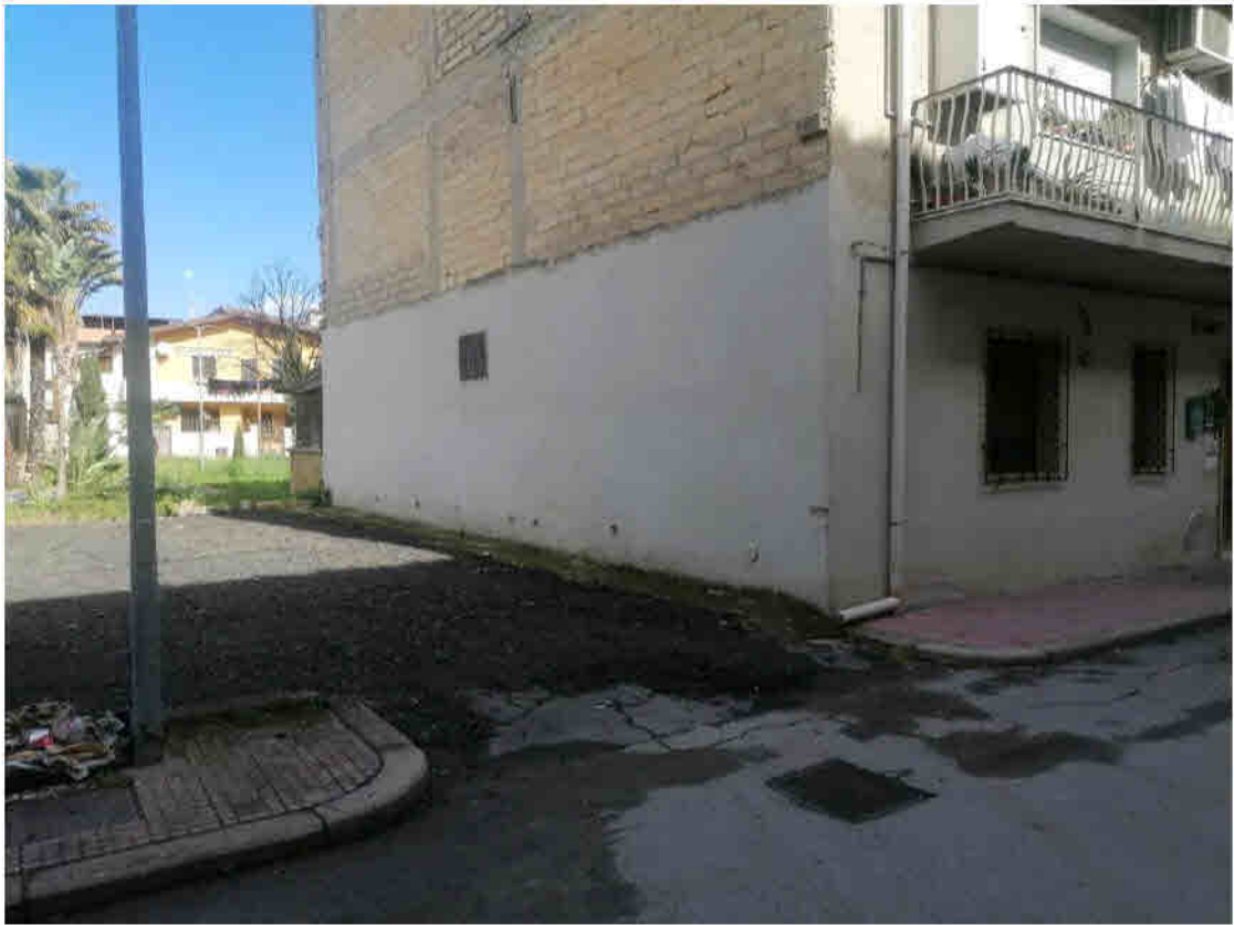
Foto n° 3 – Unità immobiliare al piano terra del fabbricato sito in Gela nella via P. Fontana n. 38. In Catasto al foglio 142 part.lla 920 sub 1; Prospetto ovest.
