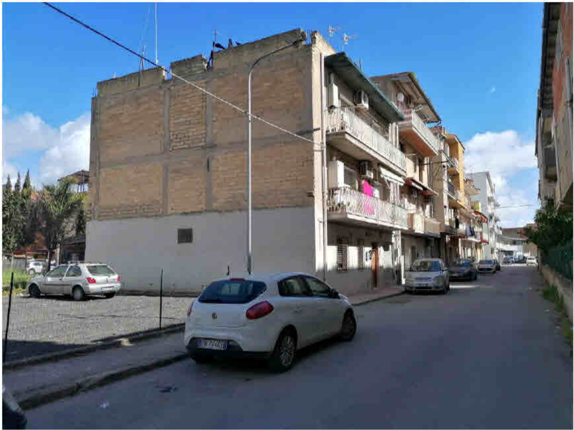
Foto n° 1 – Unità immobiliare al piano terra del fabbricato sito in Gela nella via P. Fontana n. 38. In Catasto al foglio 142 part.lla 920 sub 1; Vista d'insieme del fabbricato.
