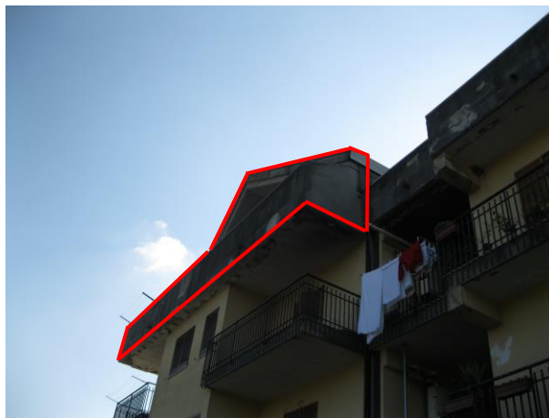
Foto 2 - Vista appartamento dall'area retrostante
