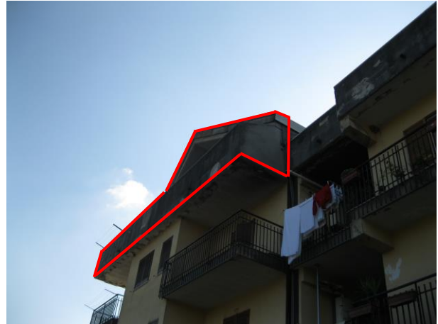
Foto 2 - Vista appartamento dall'area retrostante
