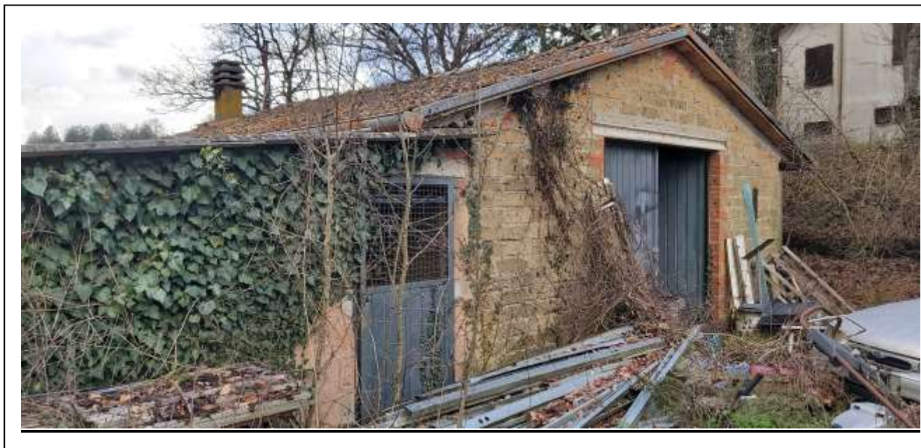
LOTTO 1 - FOTO n° 4 – Annesso agricolo (prospetto principale)
