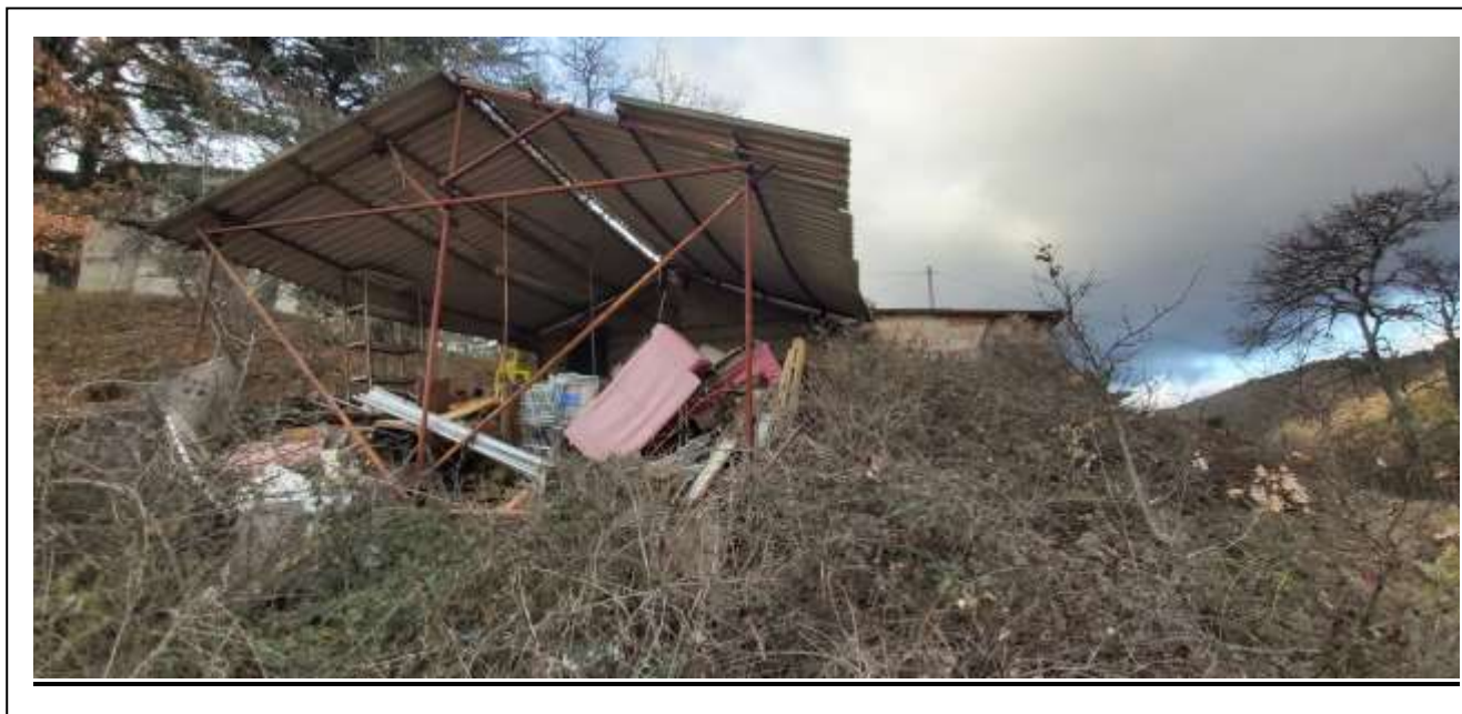
LOTTO 1 - FOTO n° 7 – Annesso agricolo (prospetto posteriore)
