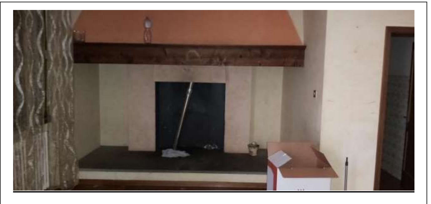
LOTTO 1 - FOTO n° 17 - Edificio Principale (zona interna piano primo)
