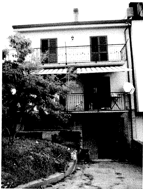
FOTO 3 Vista esterna ingresso al piano terra
