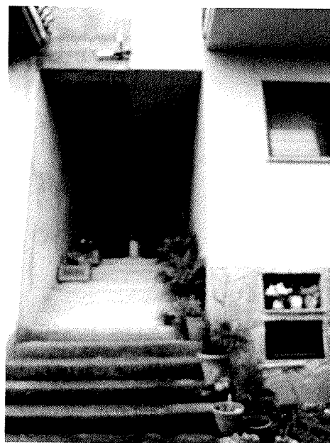
FOTO 4 Vista Scala comune di ingresso all'abitazione
