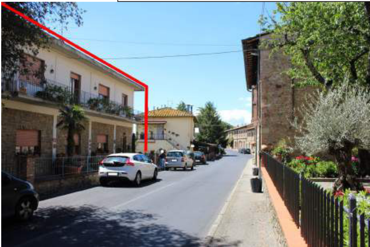
Foto n° 4 – Vista sul fabbricato dalla Via S. Vivaldo
