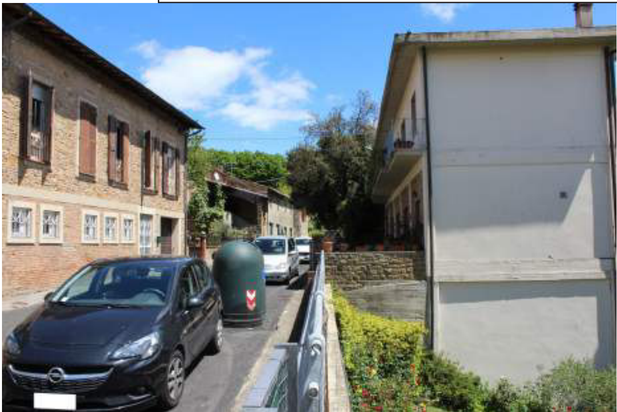
Foto n° 6 – Prospetto laterale del fabbricato, sulla destra
