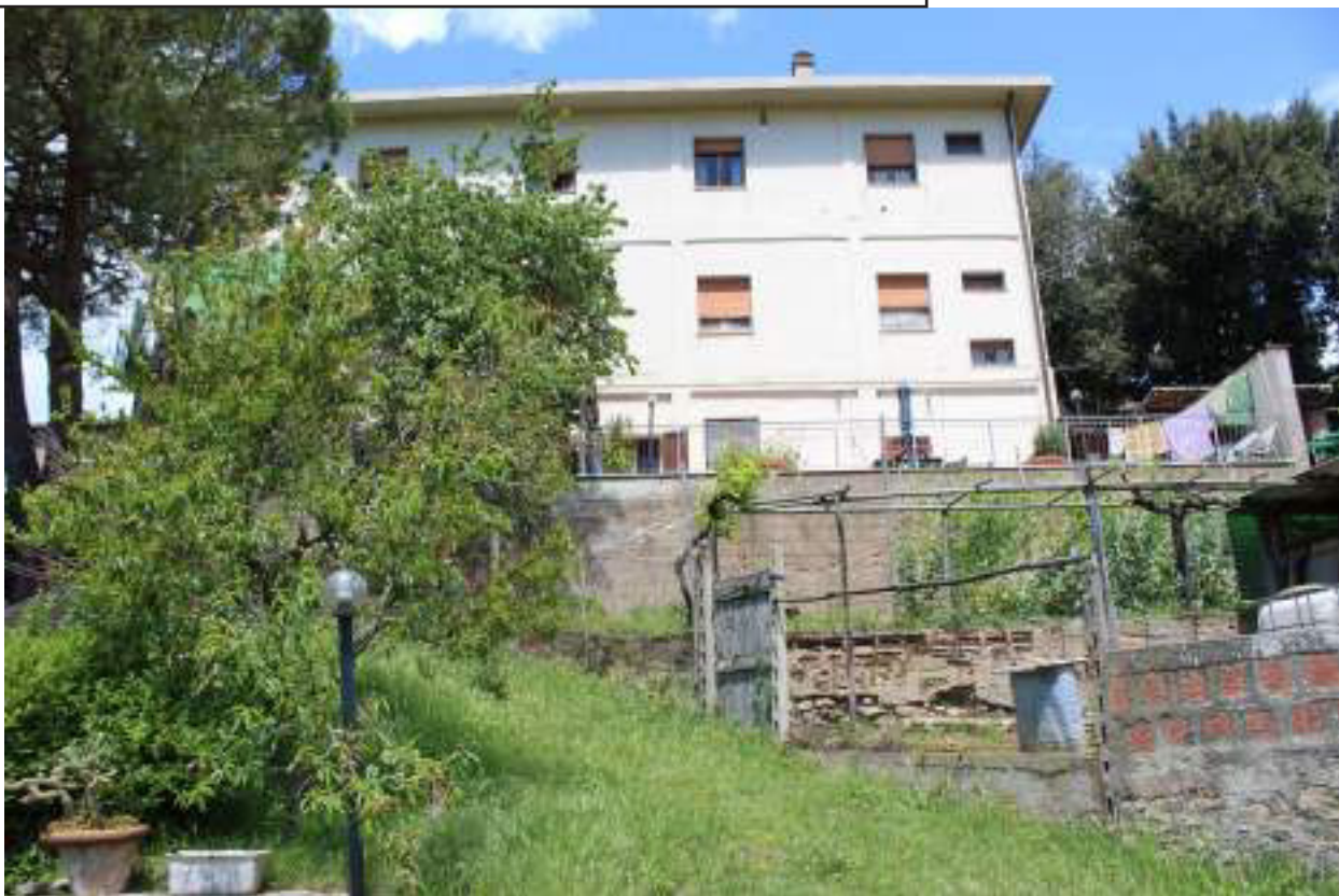
Foto n° 19 – Prospetto tergale del fabbricato
