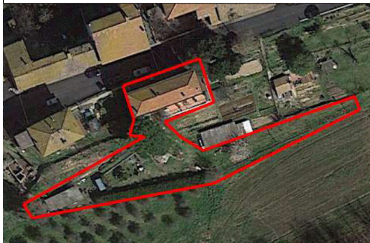
Foto n° 2 – Vista aerea dei beni in esecuzione
