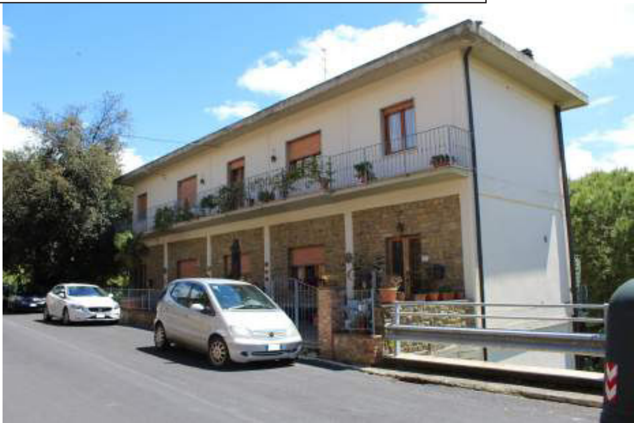
Foto n° 5 – Prospetto principale del fabbricato
