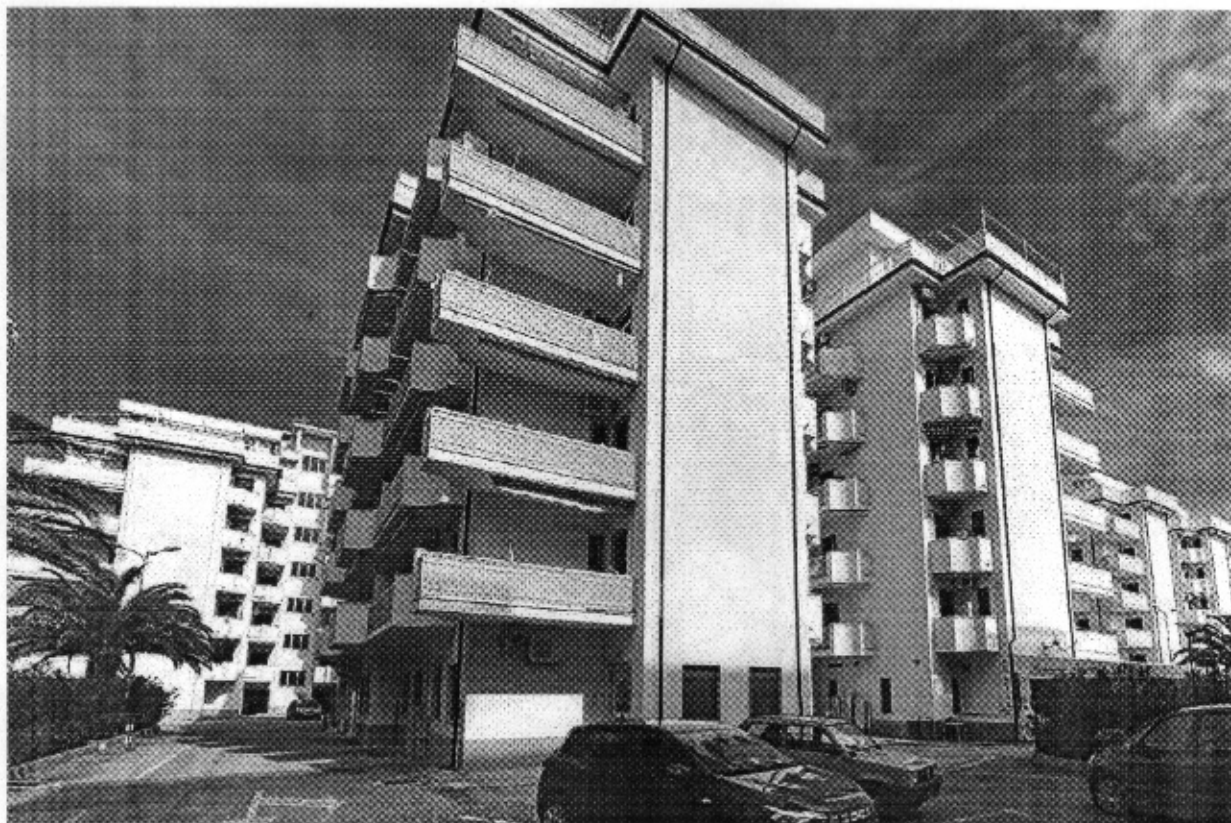
Foto dell'edificio antecedente al sopralluogo privo di ponteggio, tratta da Internet
