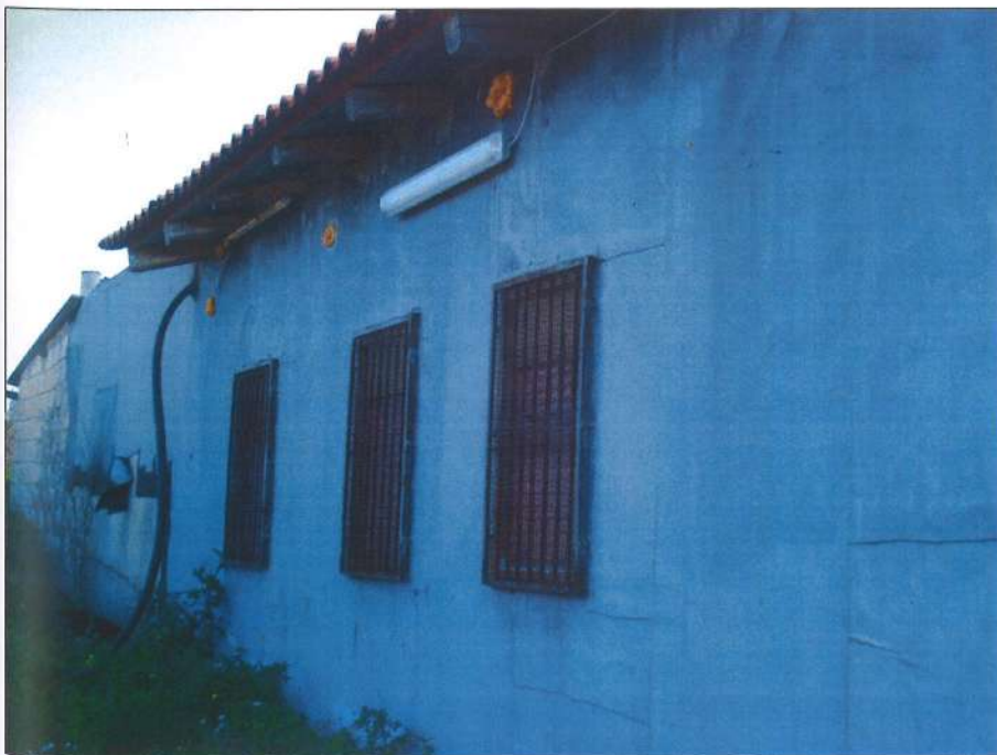
Prospetto nord fabbricato.
