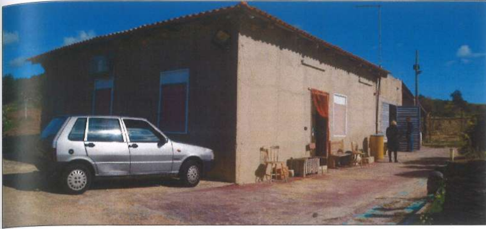
Prospetto sud-ovest fabbricato.
