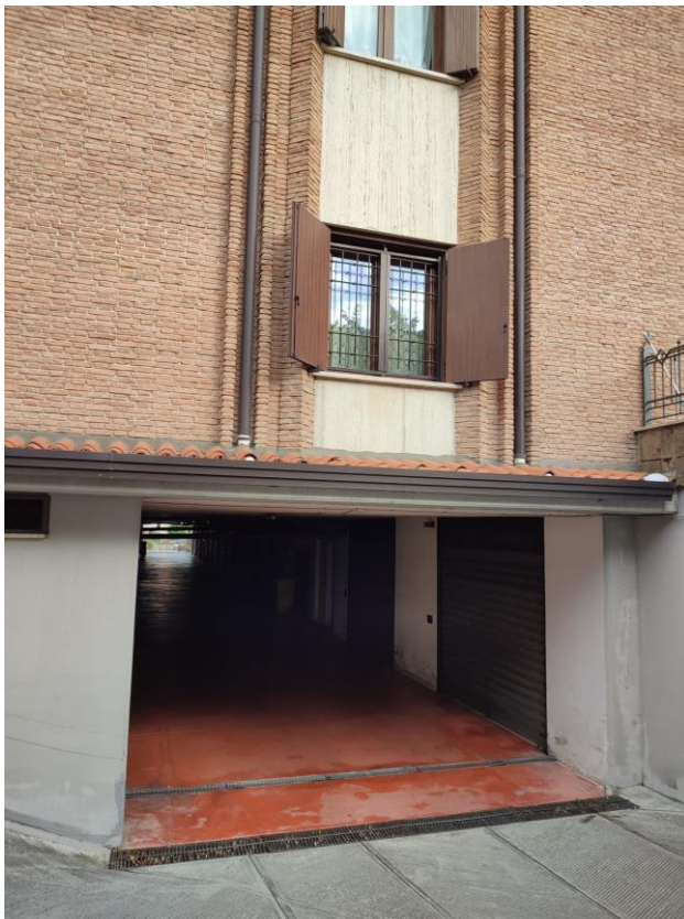
Ingresso carrabile piano S1
