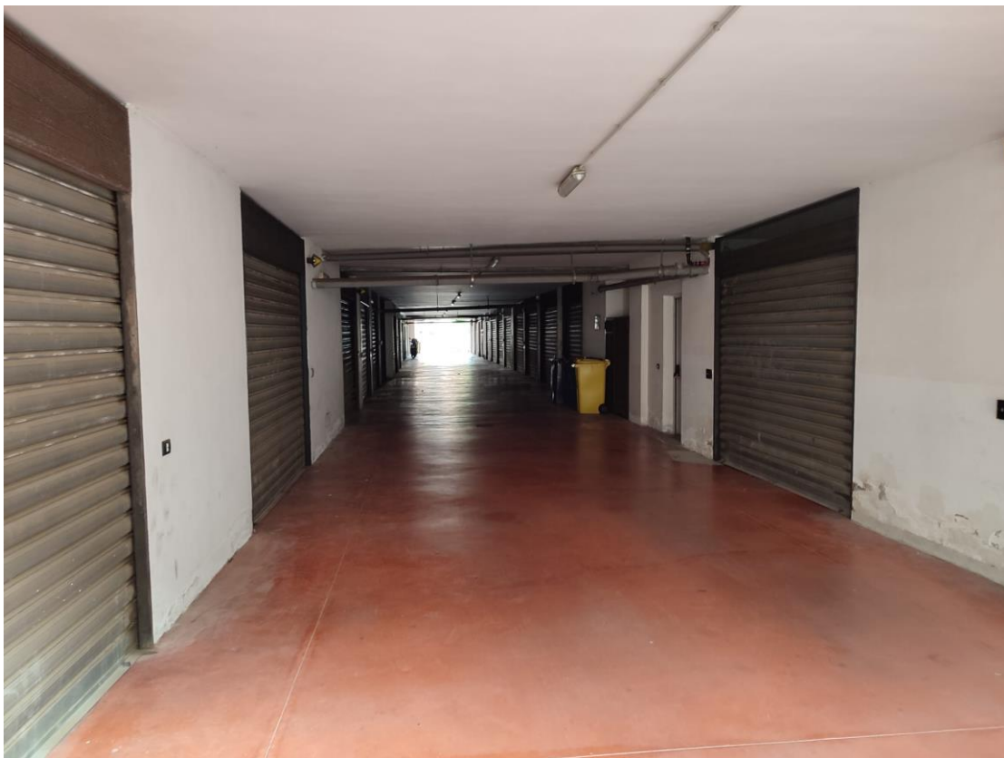
Corsia di manovra piano S1
