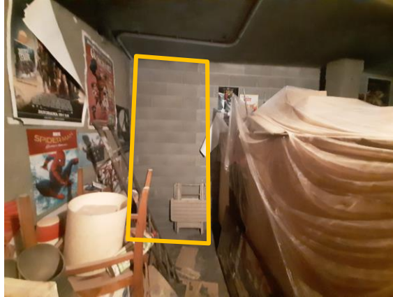
Foto n. 7 – muro che impedisce l'accesso alla porzione di autorimessa che attualmente è stata incorporata nella adiacente unità immobiliare
