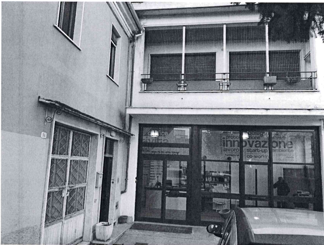
foto n°4 - vista ingressi locale commerciale e balcone coperto al piano primo
