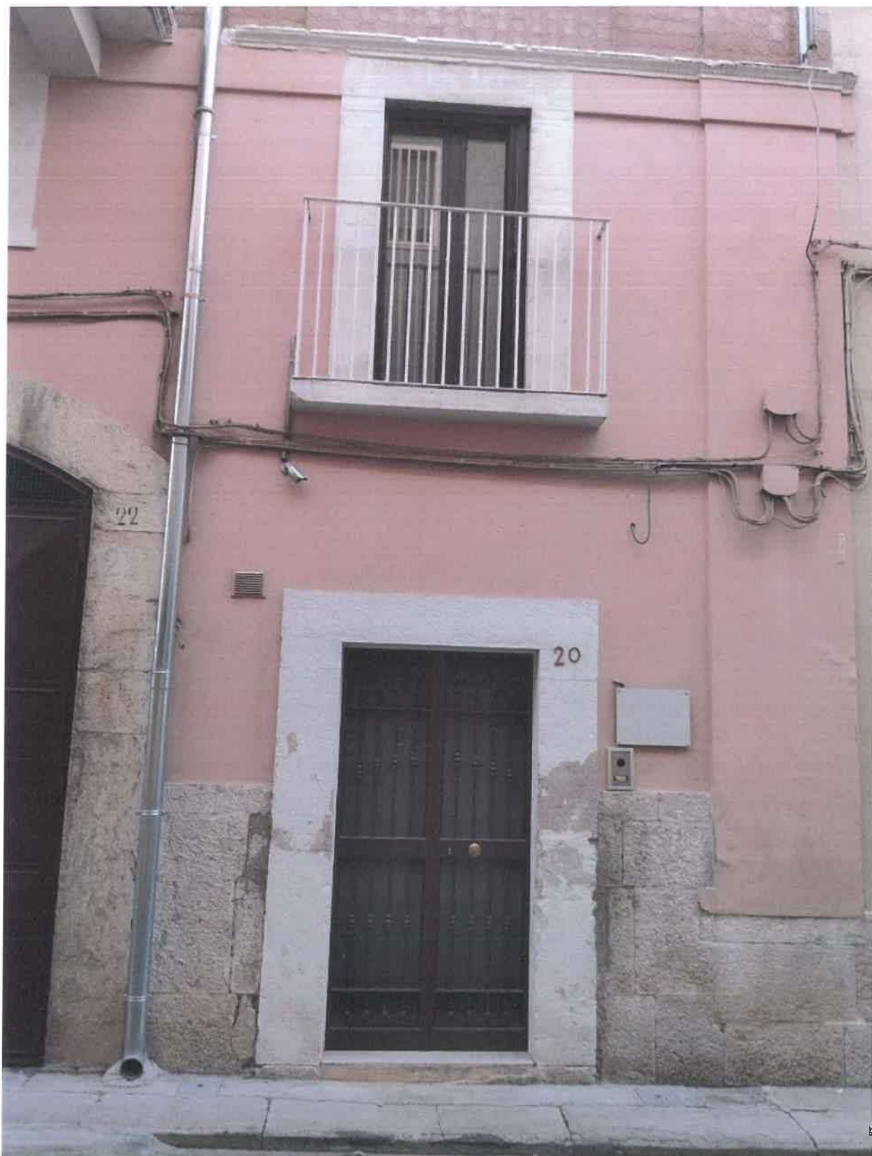
Foto 1. Via Esquilino, 20. Locale deposito. Piani terra e ammezzato.
