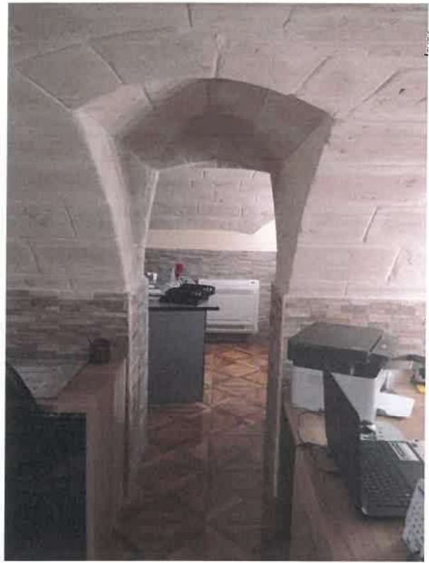
Foto 14. Piano ammezzato. Passaggio al vano 3.
