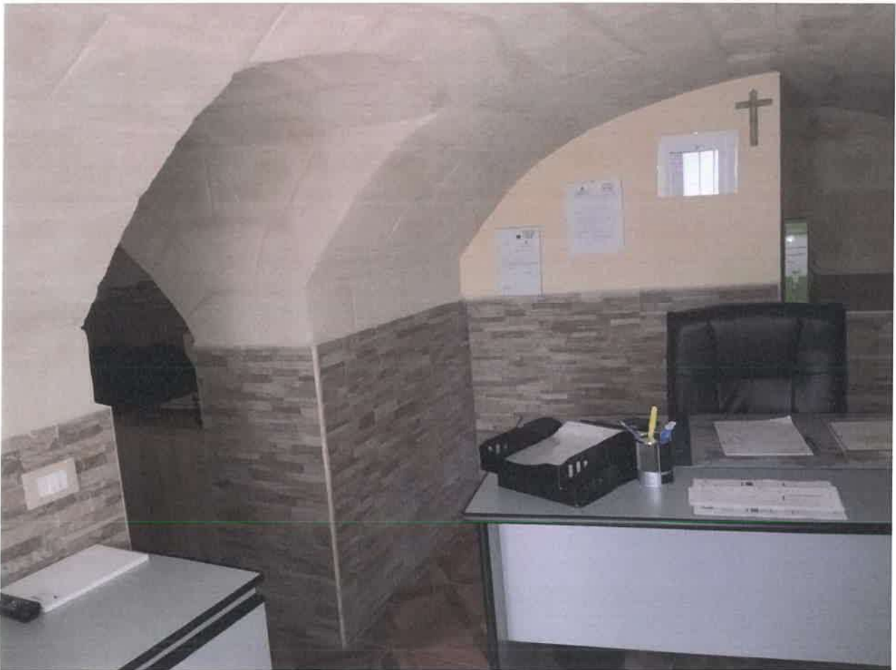
Foto 15. Piano ammezzato. Vano 3.
