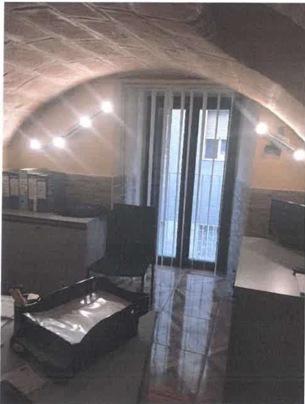
Foto 17. Piano ammezzato. Vano 3.
