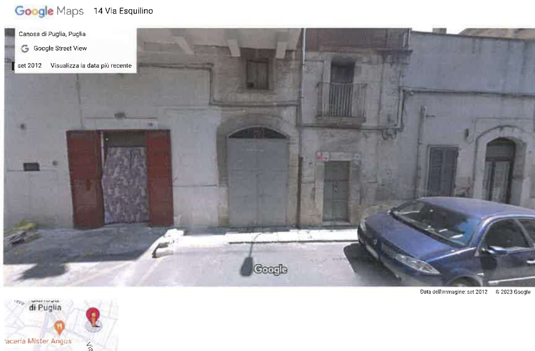
Foto 3. Via Esquilino, 20. Locale deposito. Piani terra e ammezzato. Anno 2012.
