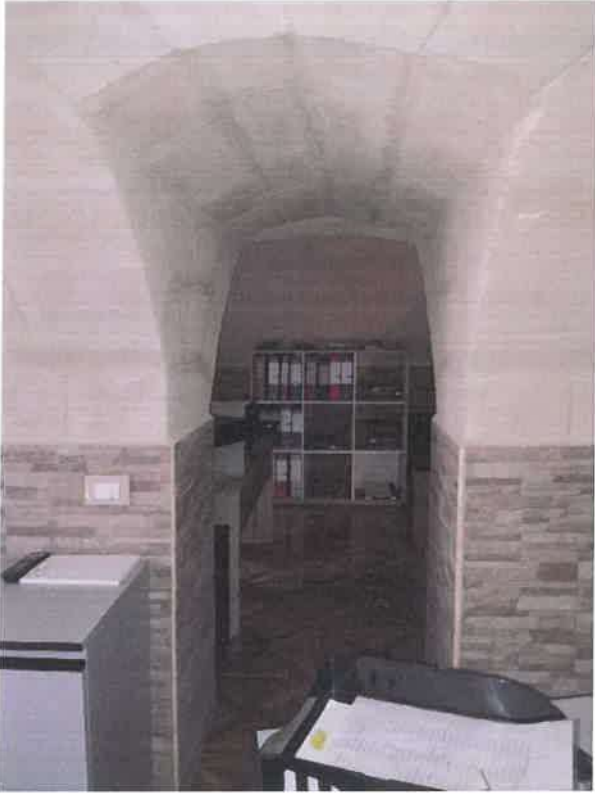
Foto 13. Piano ammezzato. Passaggio al vano 2.
