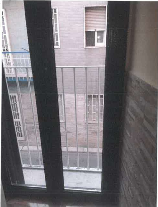
Foto 18. Piano ammezzato. Vano 3. Infisso.
