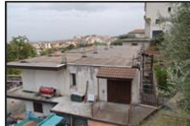
foto della copertura
