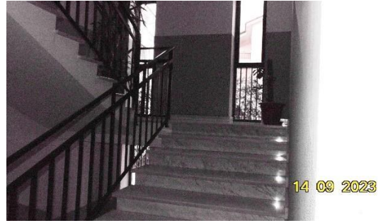
Abitazione (Vano scala condominiale)
