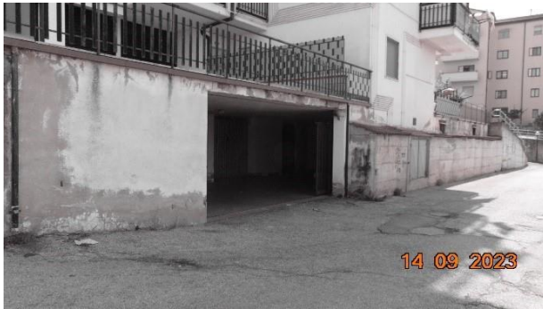
Garage (particolare: accesso dall'esterno)
