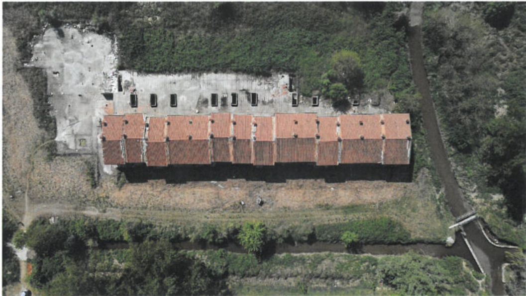
vista aerea villette in costruzione
