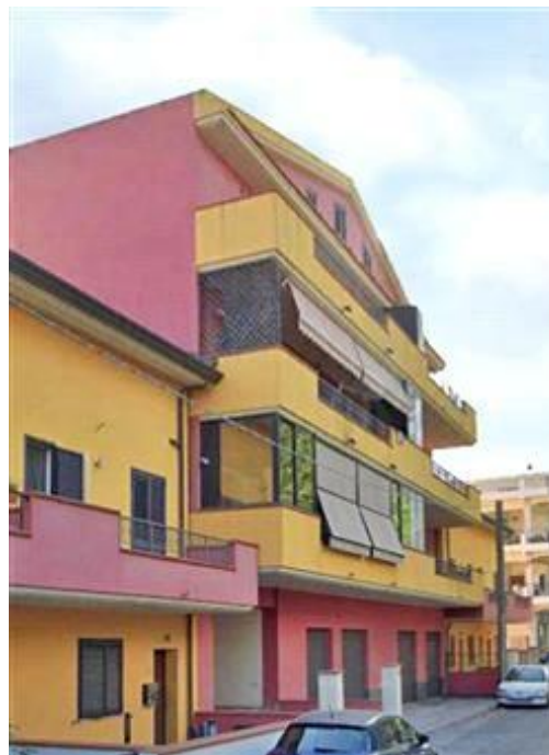
Condominio "Garibaldi" - prospetto su via Garibaldi
