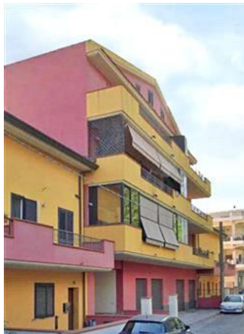
Condominio "Garibaldi" - prospetto su via Garibaldi
