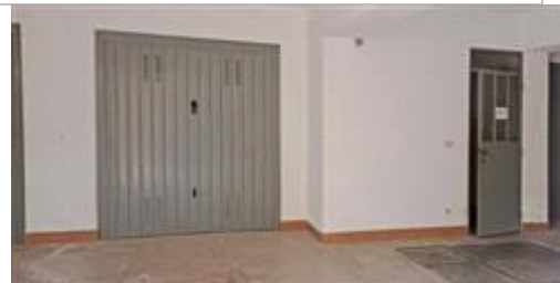
Locale deposito - esterno
