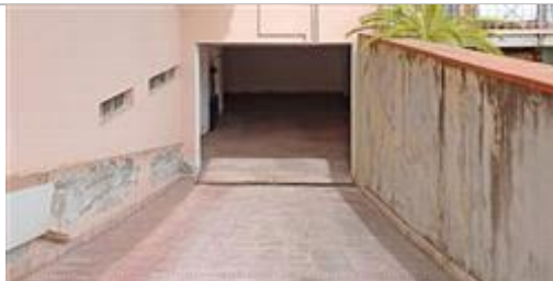
Rampa di accesso al piano cantinato
