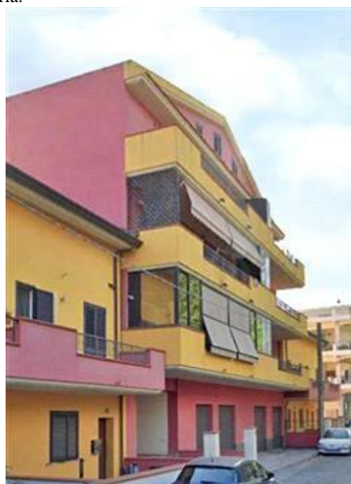
Condominio "Garibaldi" - prospetto su via Garibaldi
