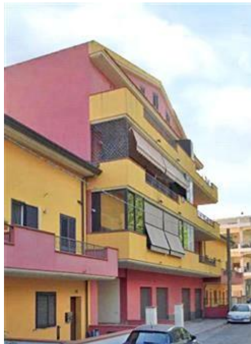
Condominio "Garibaldi" - prospetto su via Garibaldi
