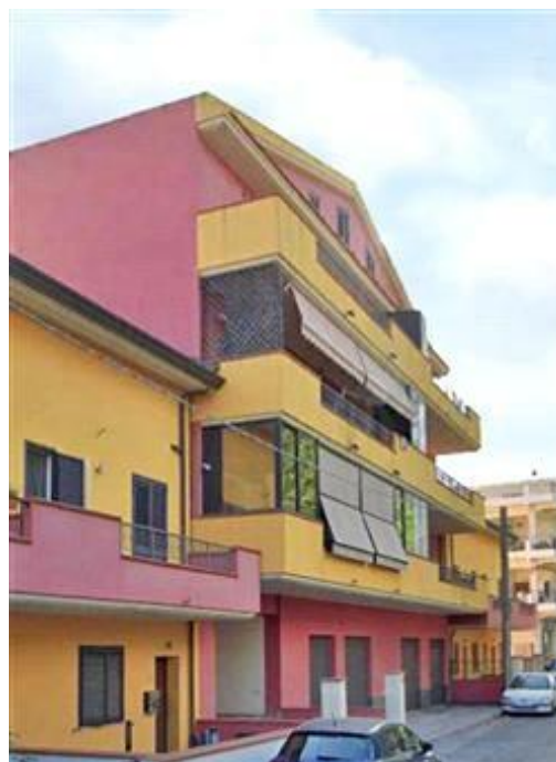
Condominio "Garibaldi" - prospetto su via Garibaldi
