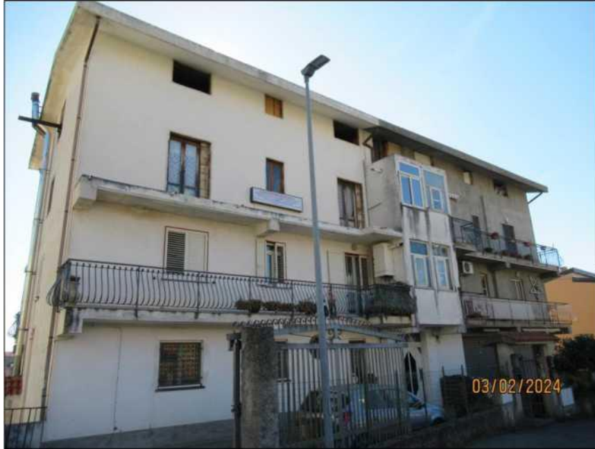
Fig. 5 - FOTO FABBRICATO (da via Milano)
