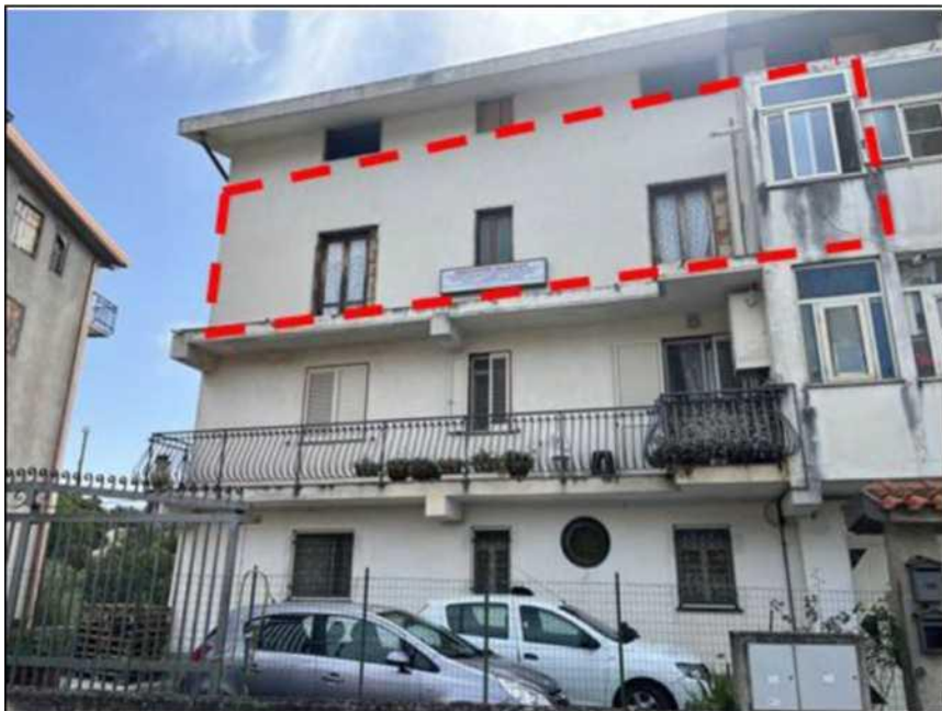
Fig. 6 - FOTO FABBRICATO da via Milano - BENI SITI IN COMUNE DI ZAGARISE (IN ROSSO UNITA' IN CORSO DI COSTRUZIONE SUB 11)
