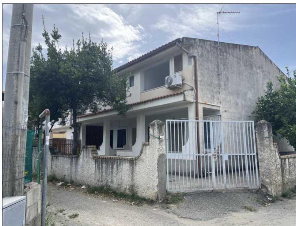
Fig. 14 — Vista esterno fabbricato
