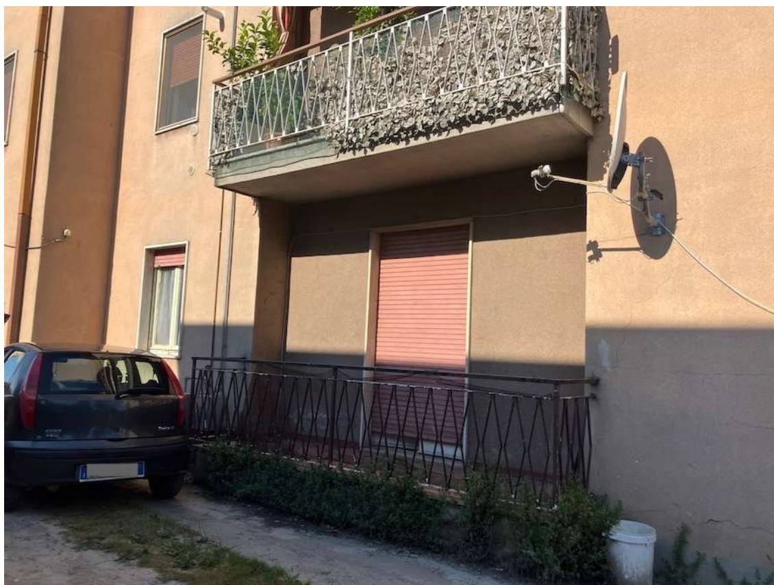
Foto n. 12 | Vista del balcone del soggiorno e della finestra della cucina.
