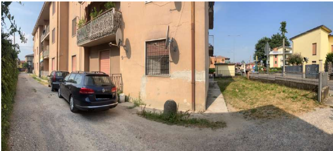
Foto n. 9 | Vista generale della facciata posteriore del condominio.
