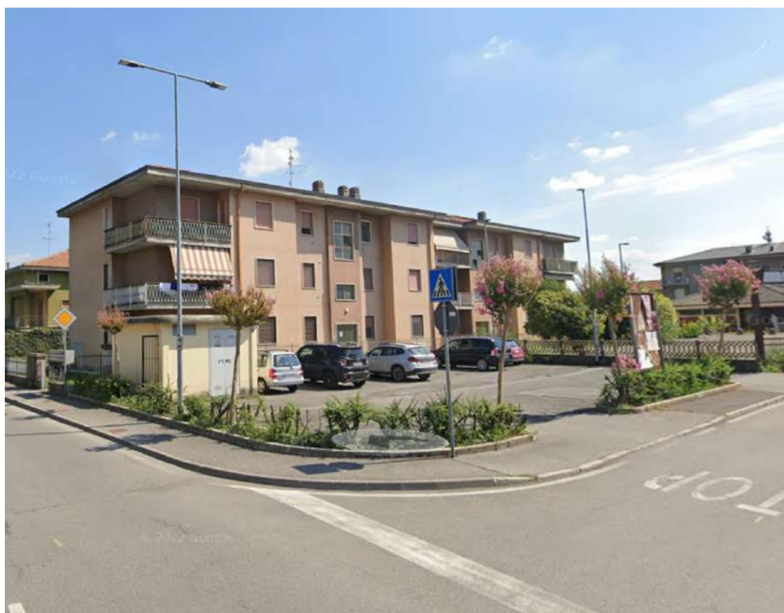
Foto n. 2 | Vista generale del condominio verso Largo Europa.
