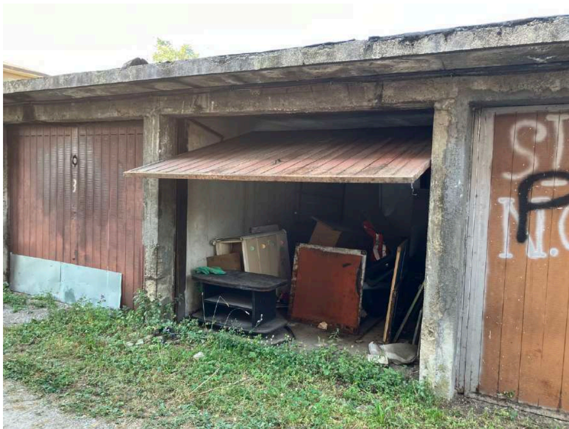
Foto n. 28 | Vista del box collegato all'appartamento.
