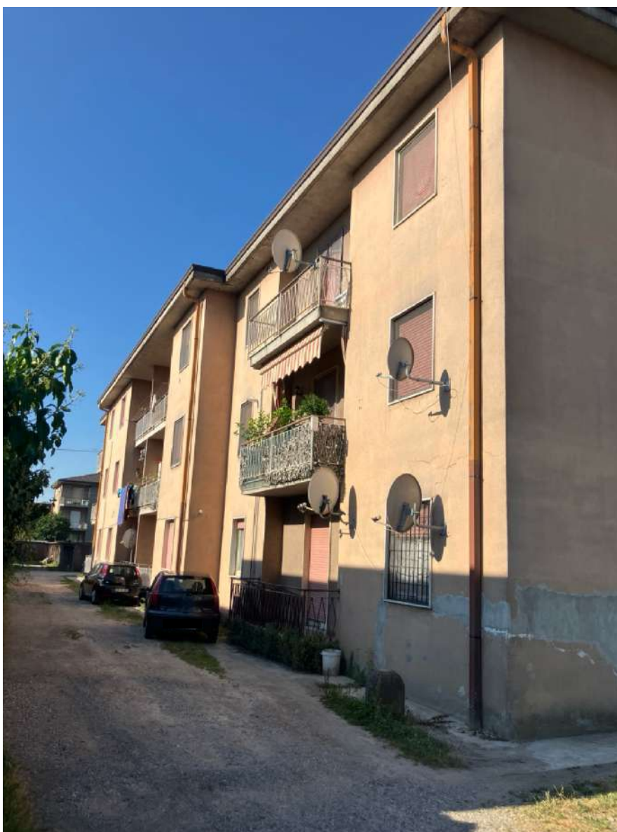
Foto n.10 | Facciata posteriore con l'appartamento oggetto della procedura al Piano Rialzato.
