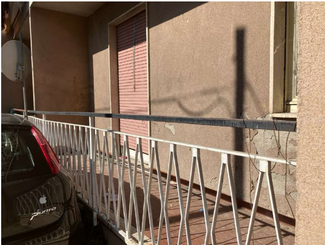
Foto n. 13 | Vista del balcone della seconda camera e della finestra del bagno.
