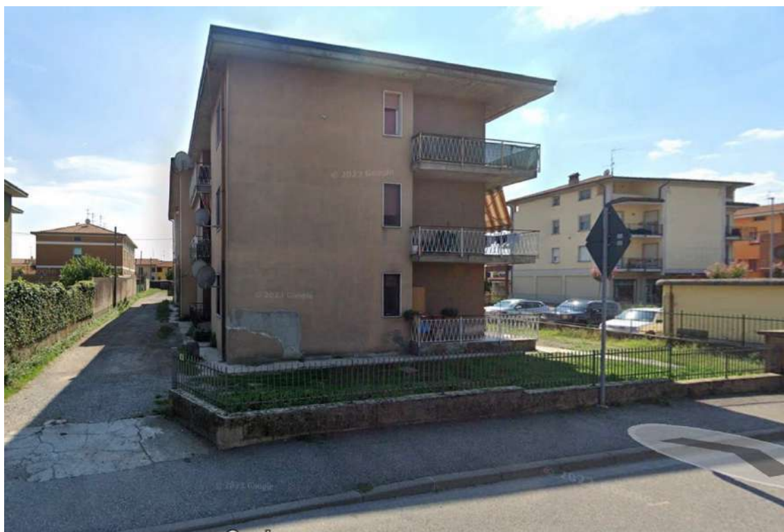
Foto n. 4 | Vista generale del condominio in corrispondenza dell'ingresso carrale.
