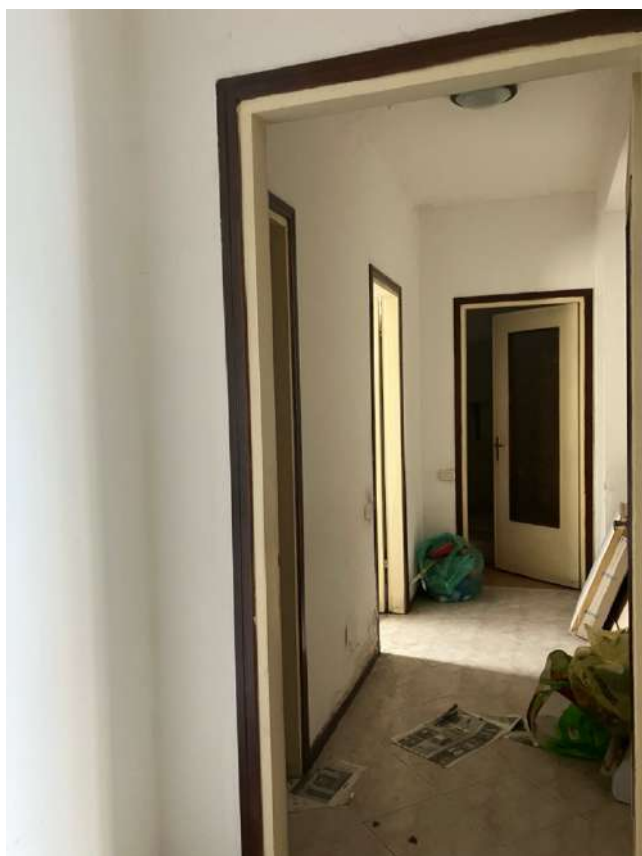
Foto n. 18 | Vista disimpegno della zona notte.
