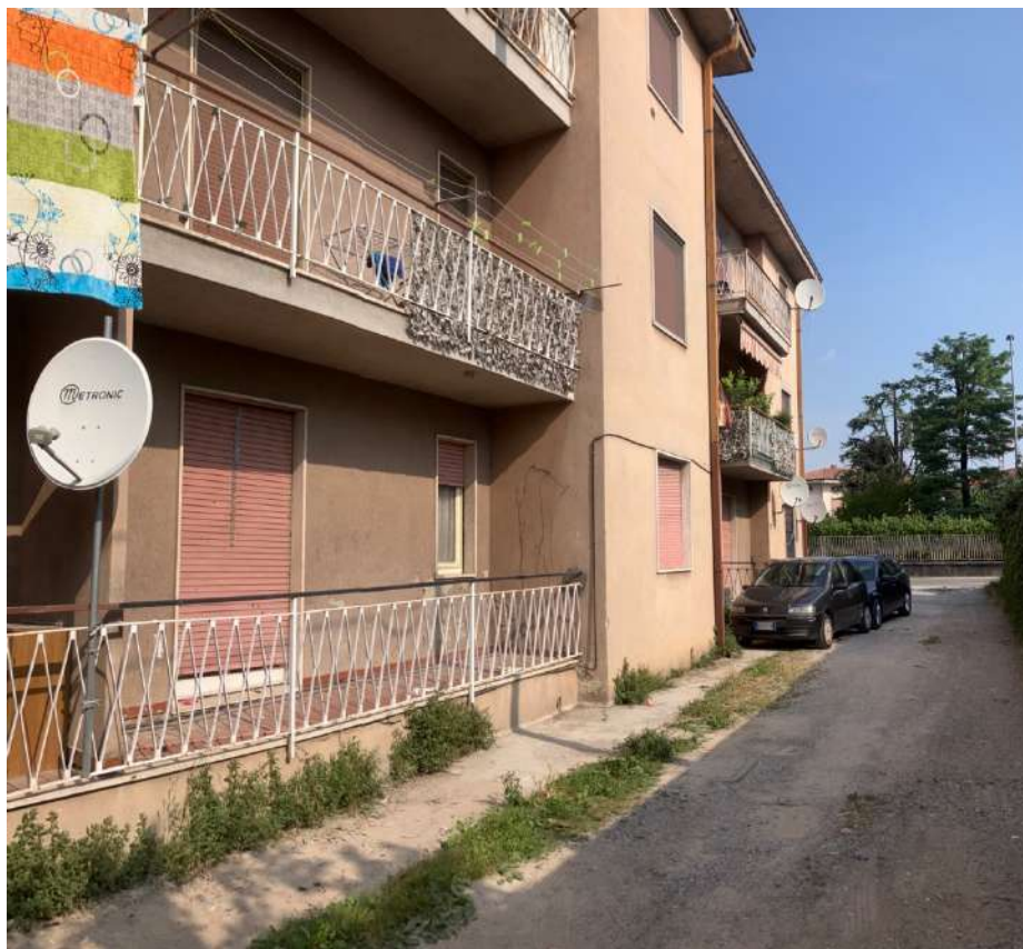
Foto n. 11 | Facciata posteriore con l'appartamento oggetto della procedura al Piano Rialzato.
