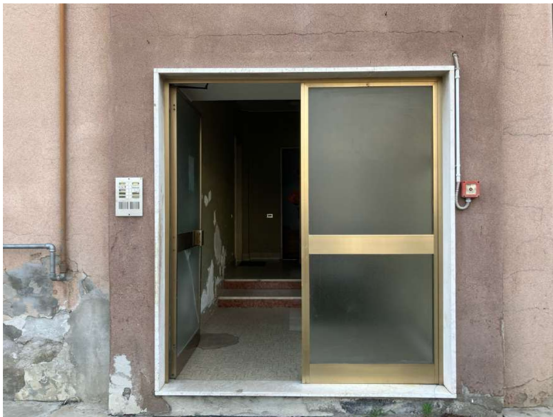
Foto n. 7 | Porta d'ingresso al condominio.
