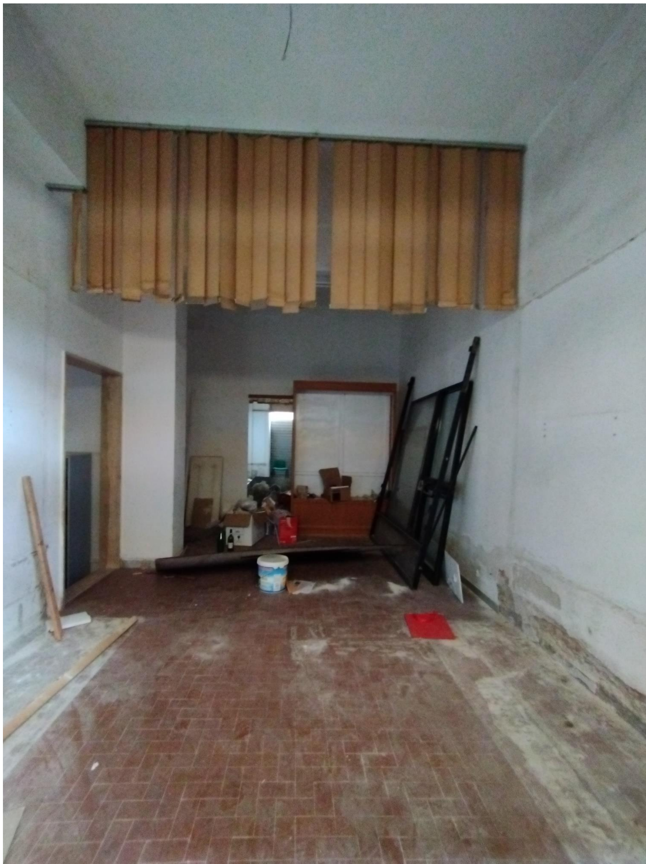
Fig. Vista locale interno LOTTO 2
