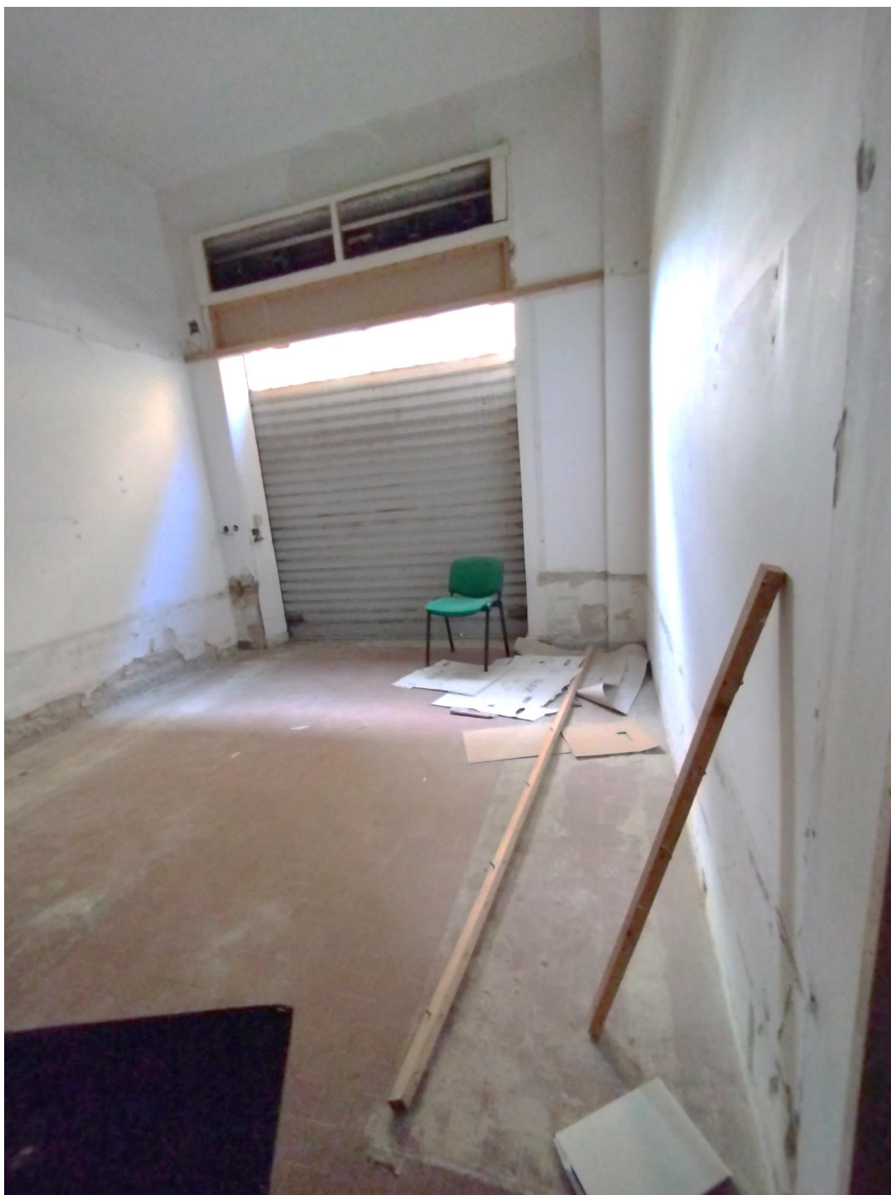
Fig. Vista Ingresso saracinesca LOTTO 2
