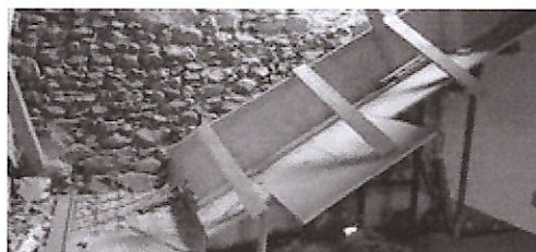
Vista della banchina precaria di accesso al piano sottotetto
