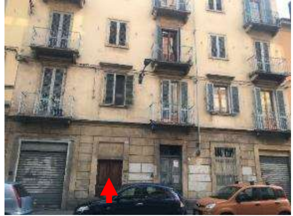
portone accesso su via
