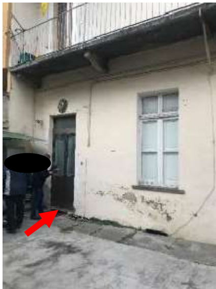
Porta accesso da cortile e finestra bagno
