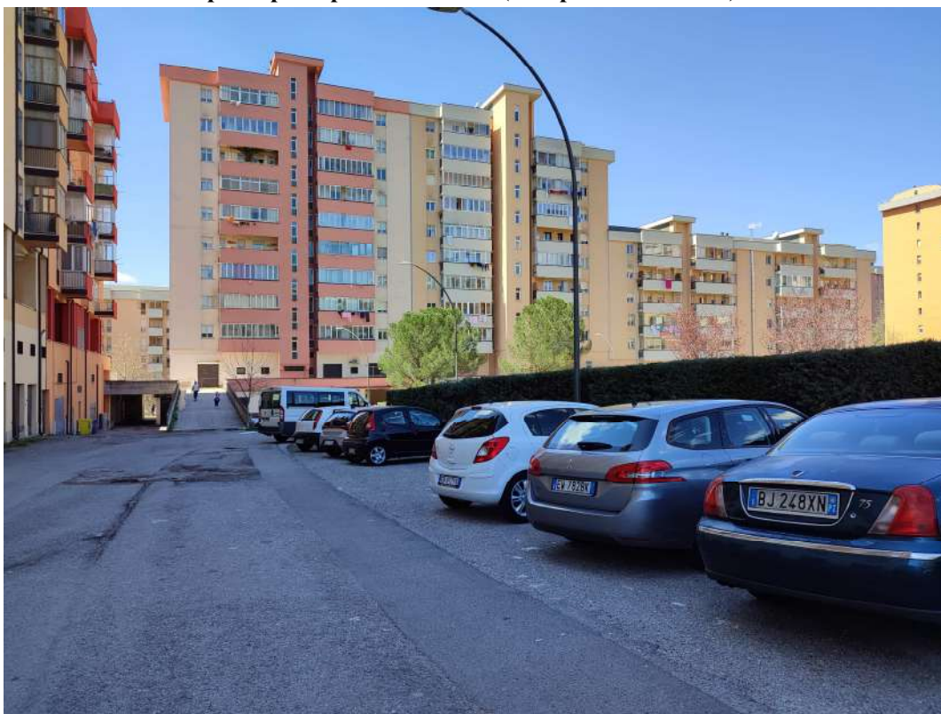
Prospetto principale fabbricato (lato piazzale S. Sofia)
