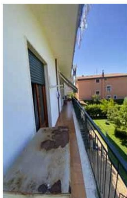
Foto n. 18 Balcone fronte ovest
