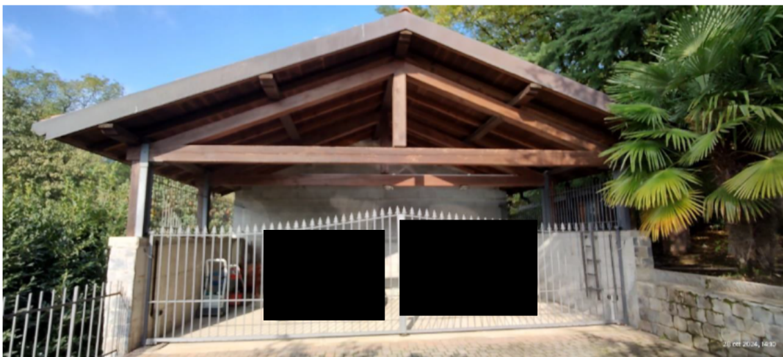
Sopra Veduta dell' autorimessa esterna
