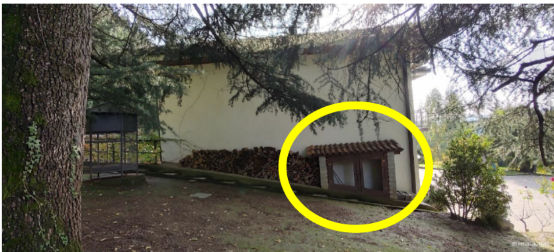
Sopra veduta della loggia realizzata in assenza di titolo in aderenza alla casa
