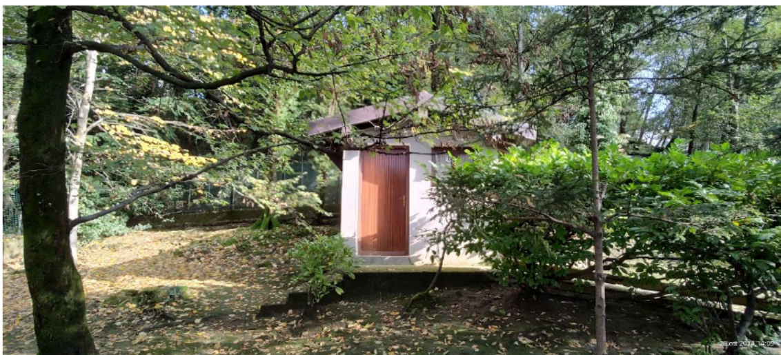
Sotto veduta di alcuni dei fabbricati accessori realizzati senza titolo
