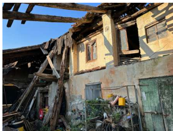
Vista del fronte principale.
