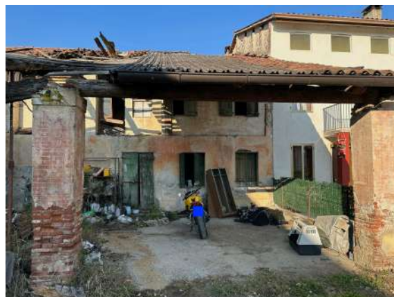
Vista dalla corte comune.
