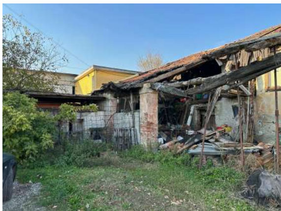
Vista dalla corte comune.
