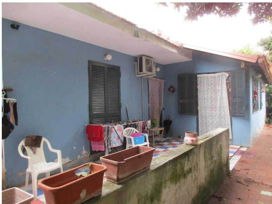
Esterno del fabbricato
