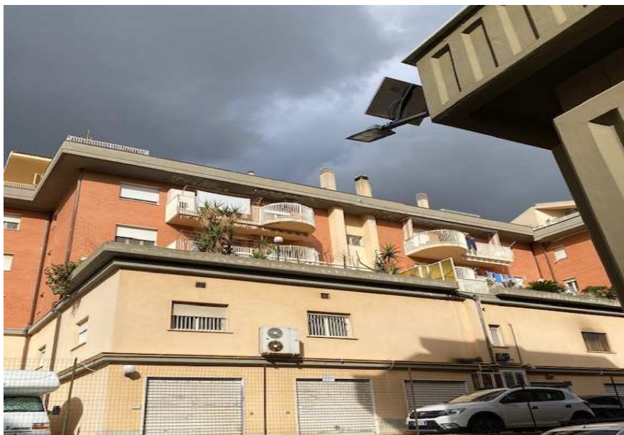
Prospetto sulla via Michelangelo
