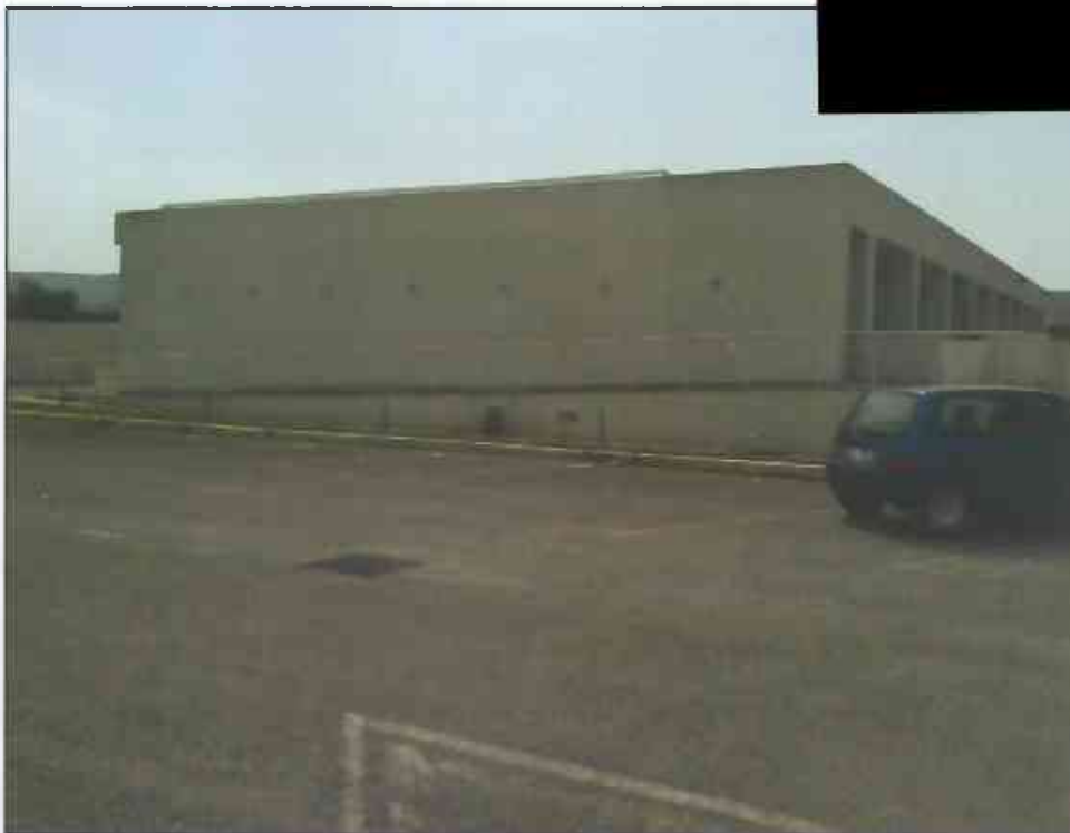
Foto 6 - Vista Prospetto laterale sinistro
