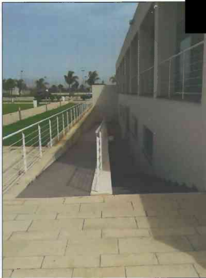
Foto 4 - Vista rampa disabili e scala di collegamento al piano seminterrato (area wellness)
