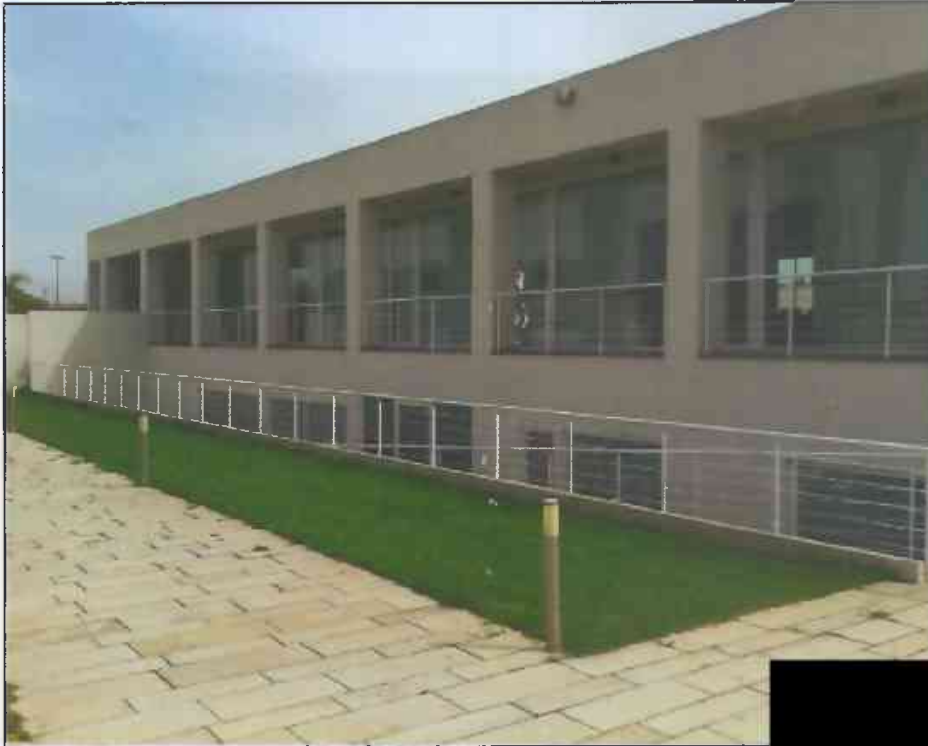
Foto 3 - Vista d'angolo prospetto principale piano rialzato
