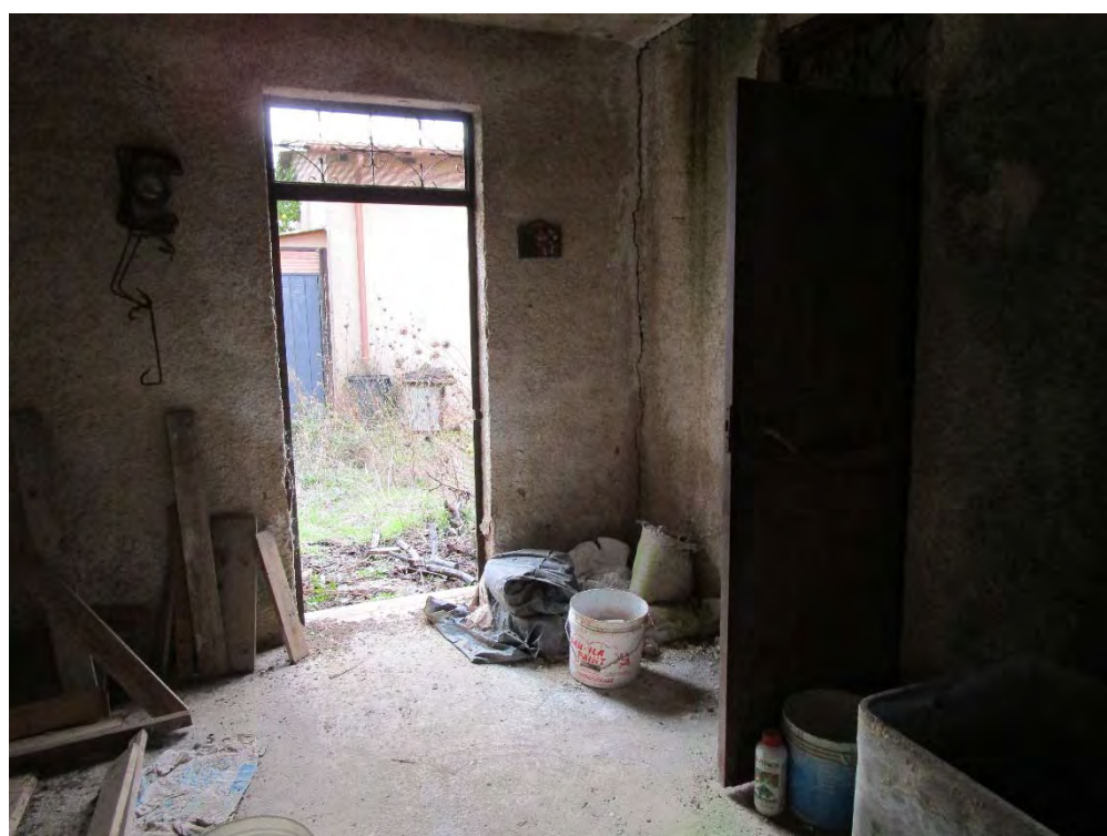
Foto 14 – Vista interna unità collabente
