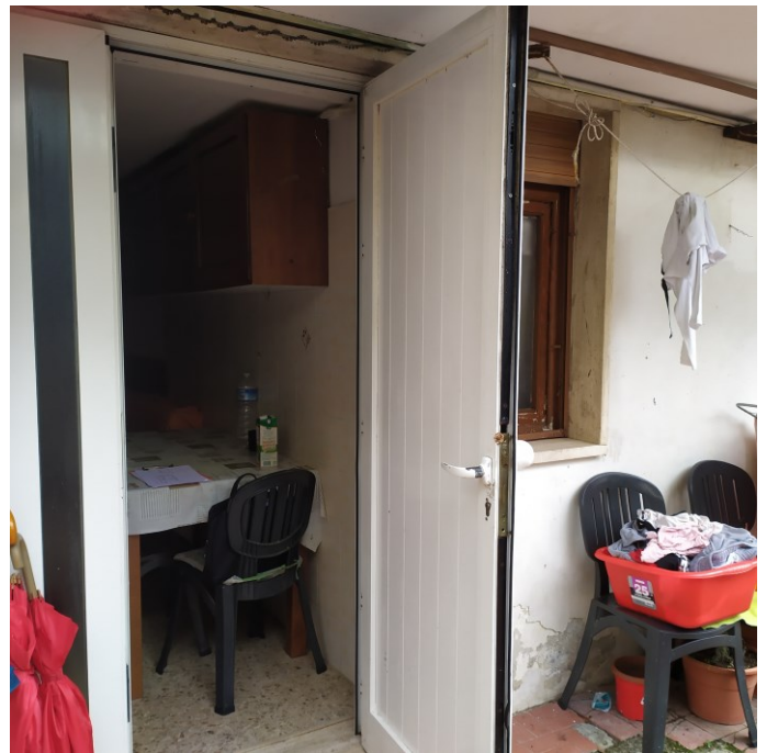
ATTUALE INGRESSO APPARTAMENTO DA RESEDE COMUNE
