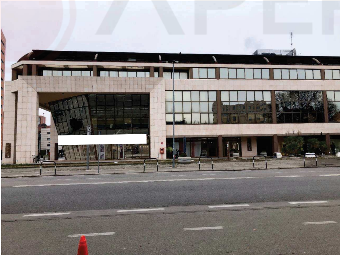
Figura 3 – Facciata del complesso immobiliare su via N. Tommaseo
