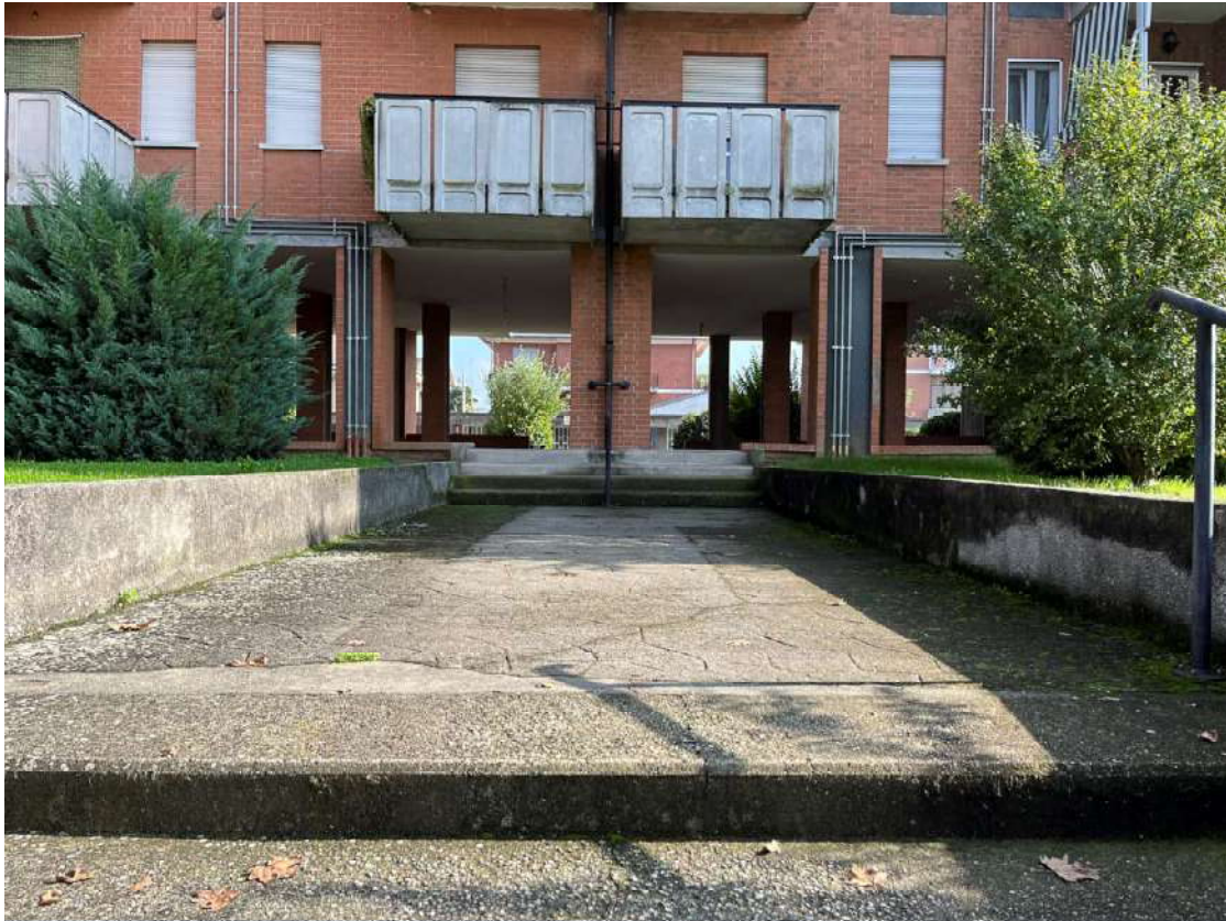
03_ingresso comune allo stabile
