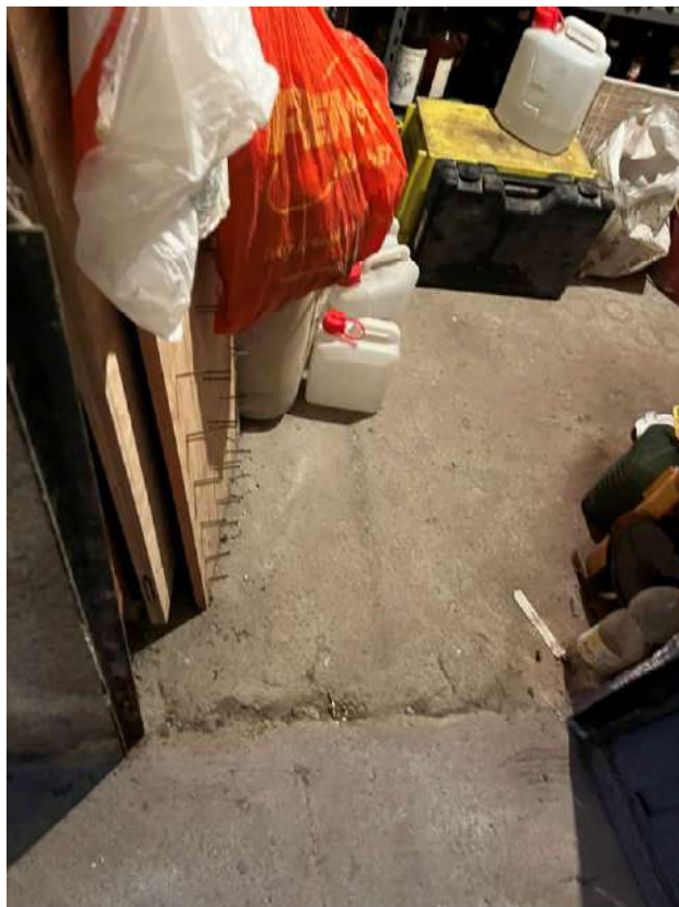
29_dettaglio pavimento cantina
