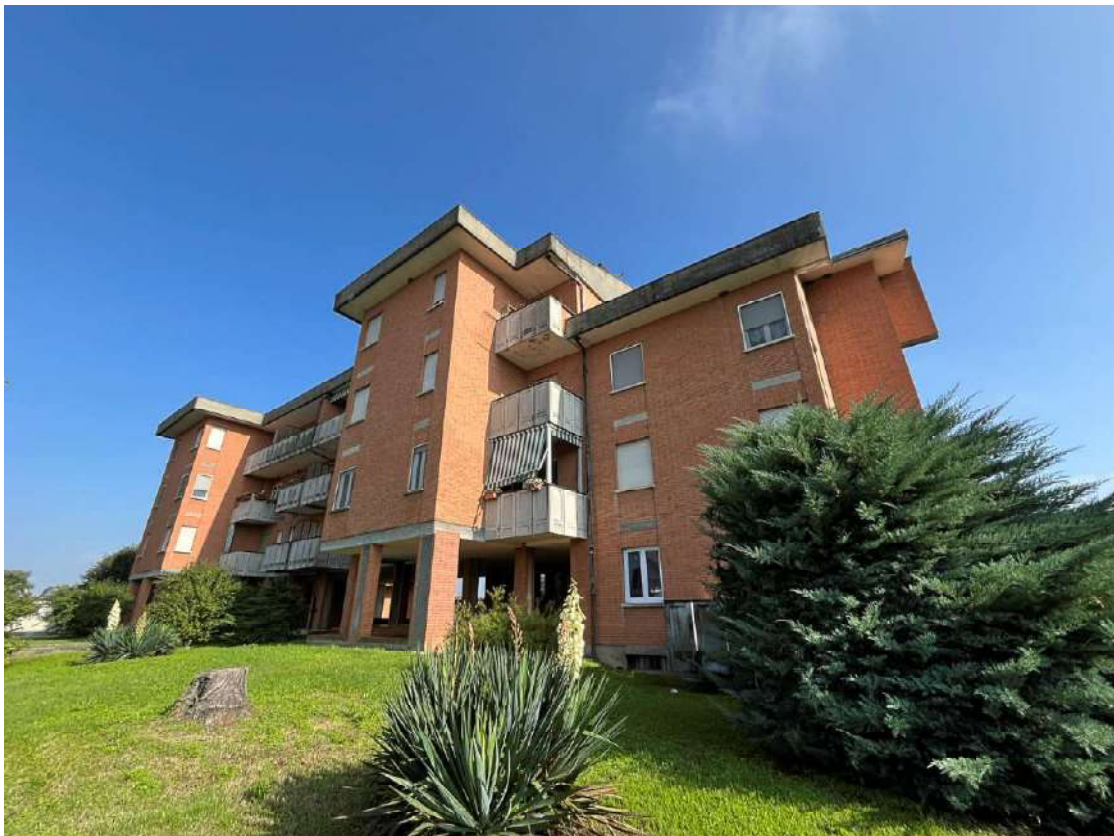
04_facciata esterno condominio
