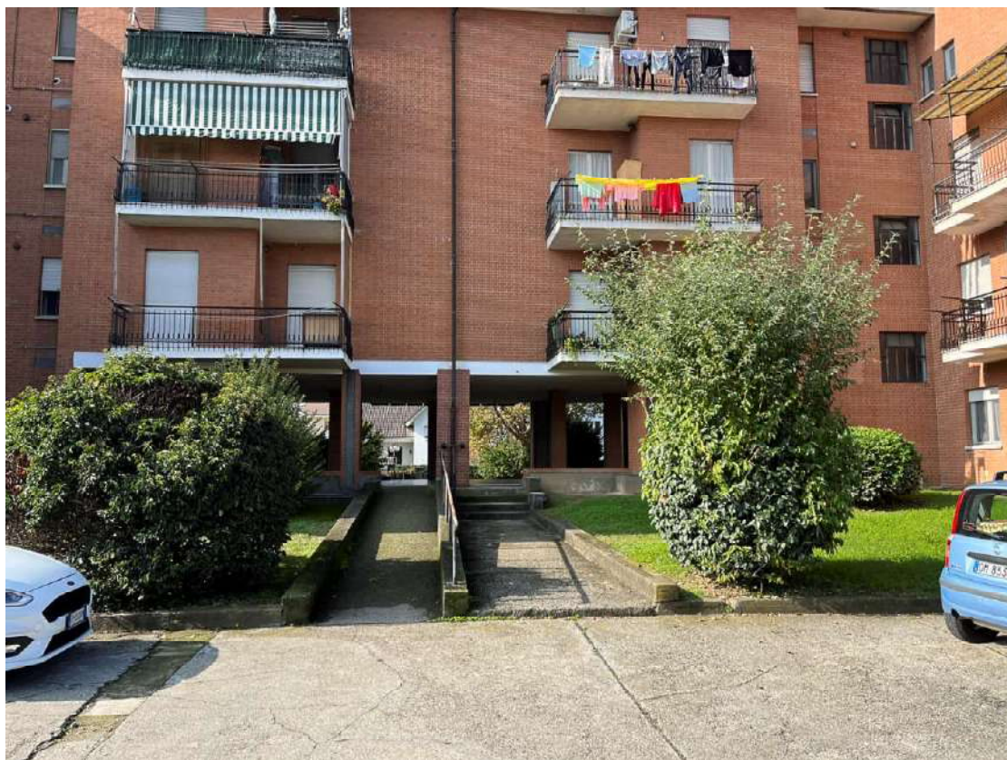
05_facciata esterno condominio
