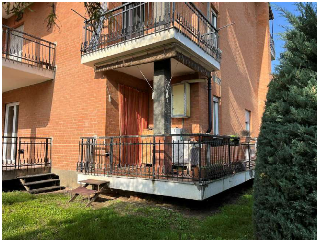
07_balcone unità immobiliare
