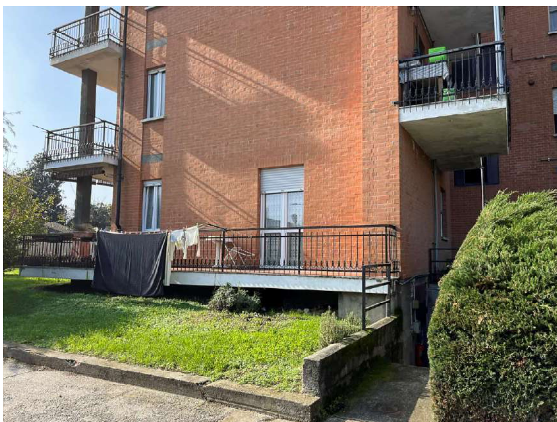
06_balcone unità immobiliare
