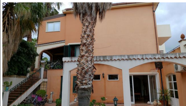
15. Vista particolareggiata del fronte NE
