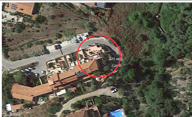
2. Vista aerea, tratta da Google Earth, con evidenziazione del fabbricato
