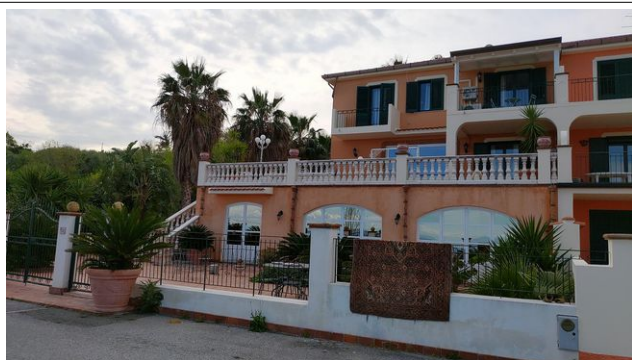
4. Prospetto lato NO del fabbricato
