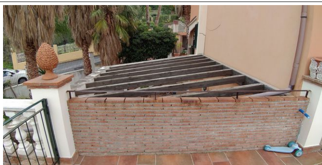
42. Vista, dalla terrazza, del pergolato sul fronte NE del piano 1S
