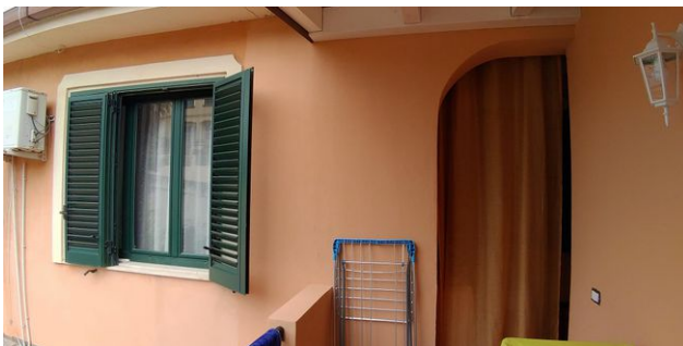
65. Vista dalla parte di struttura precaria aperta al portico
