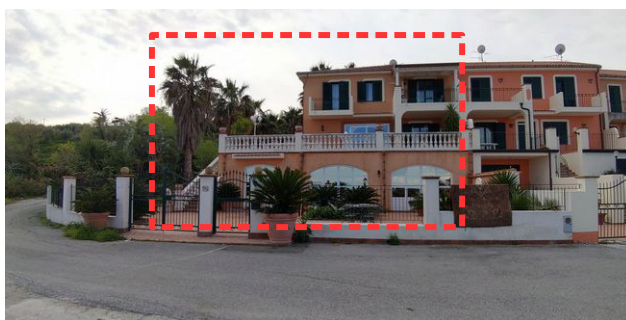
3. Esterno d'insieme, fronte mare (NO), del fabbricato
