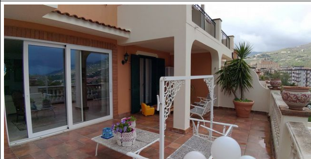
47. Fronte NO: vista di parte del terrazzo e prospetto
