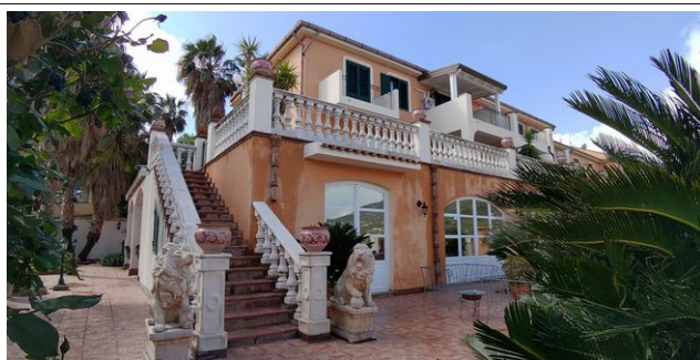
8. Vista dello spigolo lato Nord e di parte della corte al piano 1S
