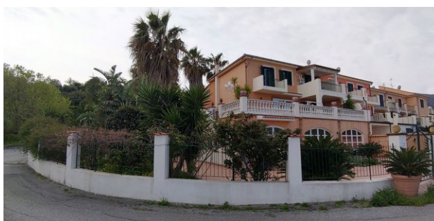
5. Vista, dalla bretella carrabile, dello spigolo Nord del fabbricato
