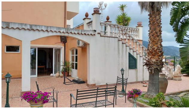
18. Ingresso dall'esterno della corte, fronte NE, al piano 1S
