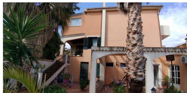
14. Vista del fabbricato dal fronte NE
