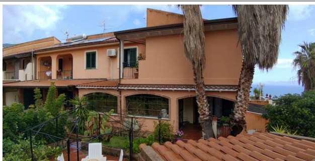
7. Vista, dalla bretella carrabile, del fronte SE del fabbricato
