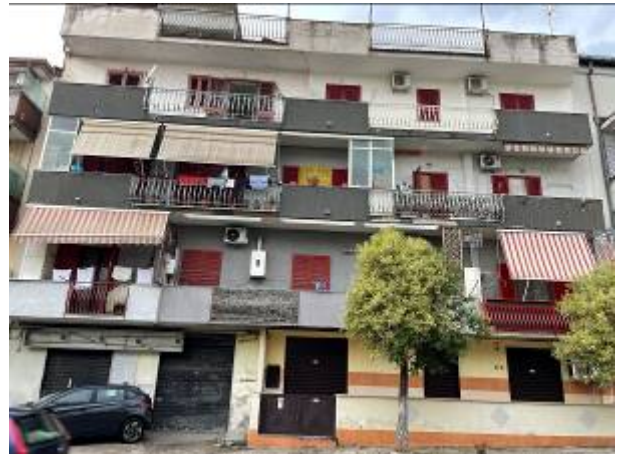
Fotografia n. 2 _ Prospetto via Diaz
