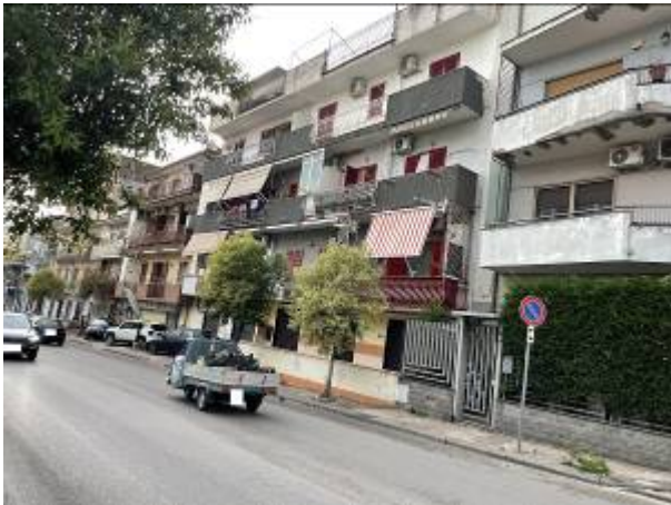
Fotografia n. 1 _ Prospetto via Diaz
