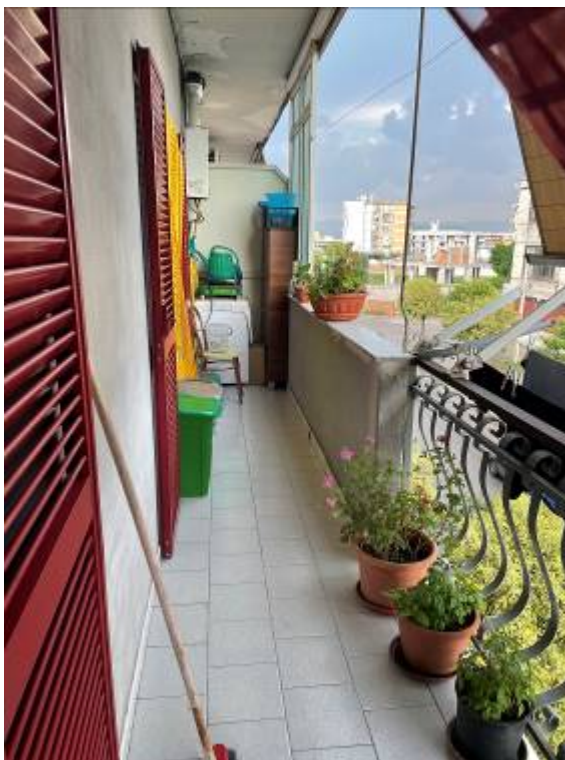
Fotografia n. 5 _ Balcone su via Diaz Vista sud/nord
