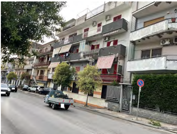
Fotografia n. 1 _ Prospetto via Diaz
