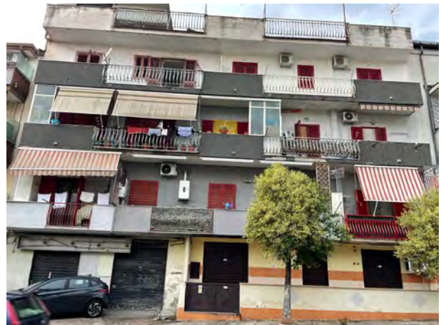
Fotografia n. 2 _ Prospetto via Diaz
