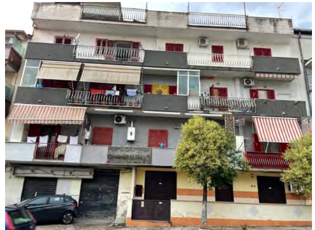
Fotografia n. 2 _ Prospetto via Diaz
