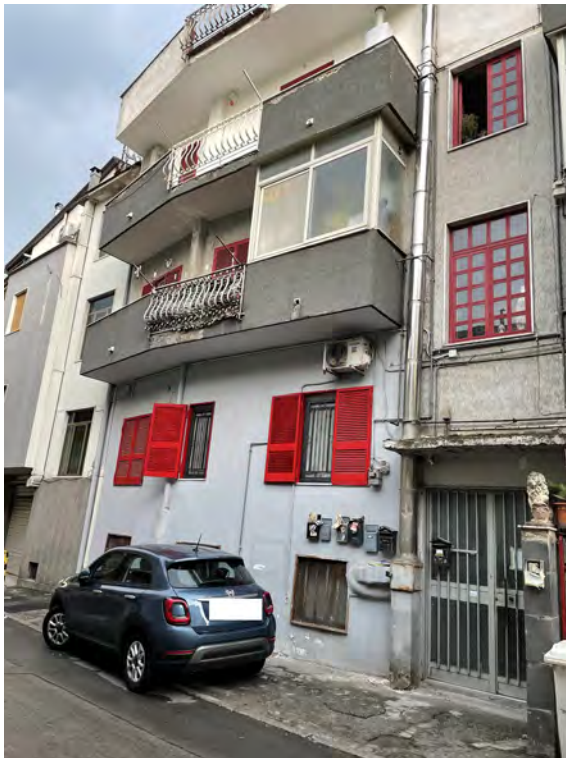
Fotografia n. 3 _ Prospetto su via Cosenza
