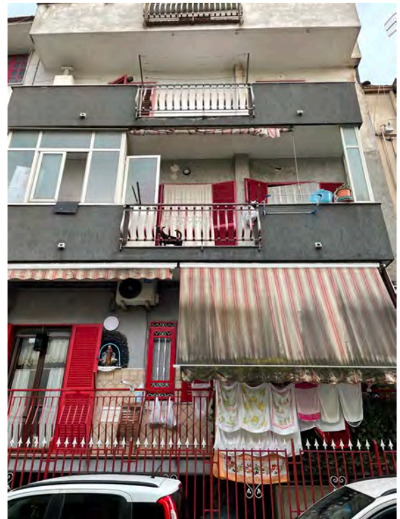
Fotografia n. 4 _ Prospetto su via Cosenza
