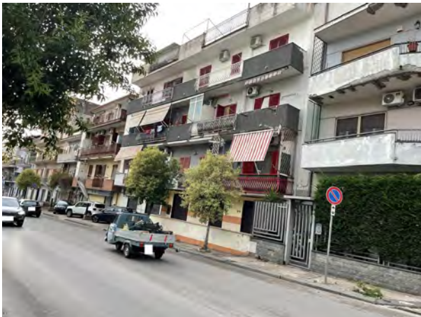
Fotografia n. 1 _ Prospetto via Diaz
