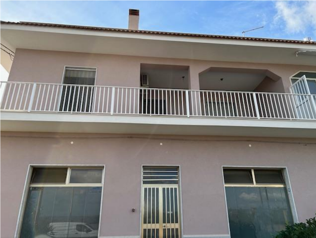
VISTA 2_ Prospetto su cortile comune
