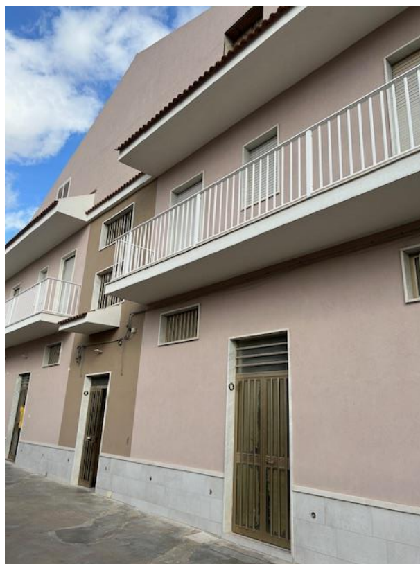
VISTA 3 _Prospetto su Cortile comune
