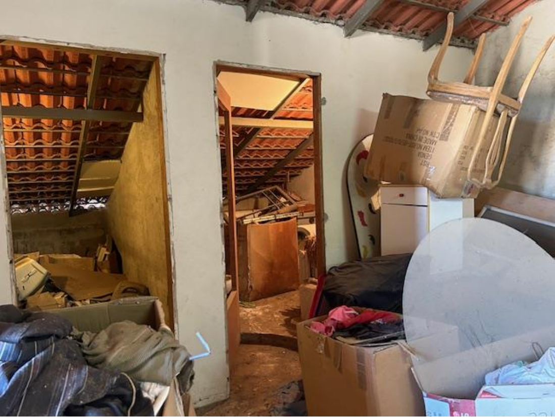
VISTE 12-13-14_Interni Locali sgombero 2°P
