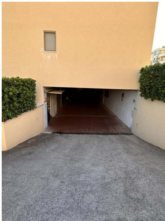
Foto 20 – Rampa rimessa auto
