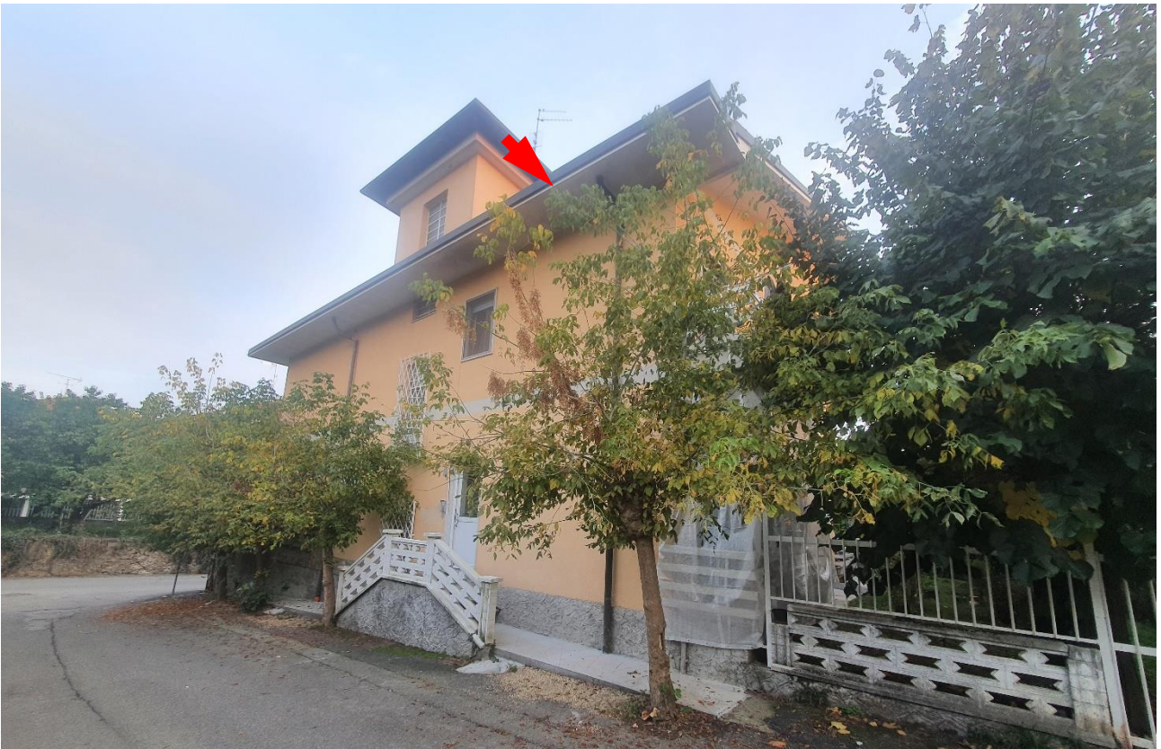
Fig. 2 Vista generale fabbricato con indicazione dell'ubicazione dell'alloggio
