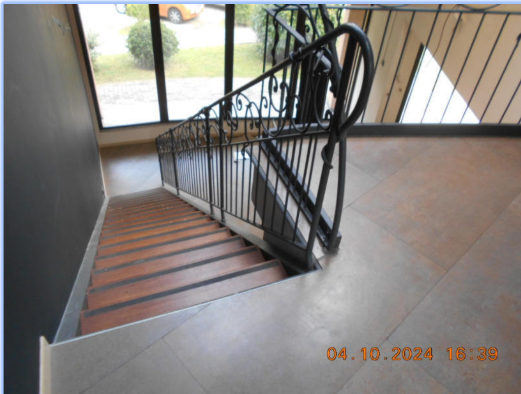
FOTO 07 SCALA DI COLLEGAMENTO AL SOPPALCO
