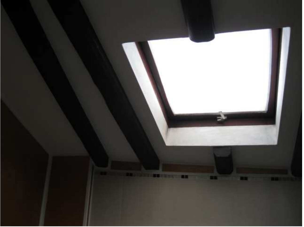
FOTO 27: particolare di lucernario nella copertura
