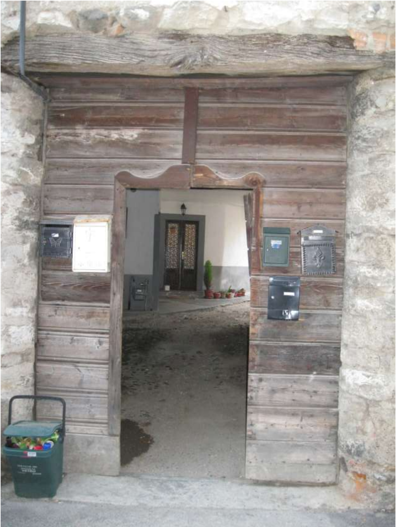
FOTO 6: l'accesso al cortile da via della Croce n. 11 (accesso comune) con serramento tipico originale del sito e di valore storico
