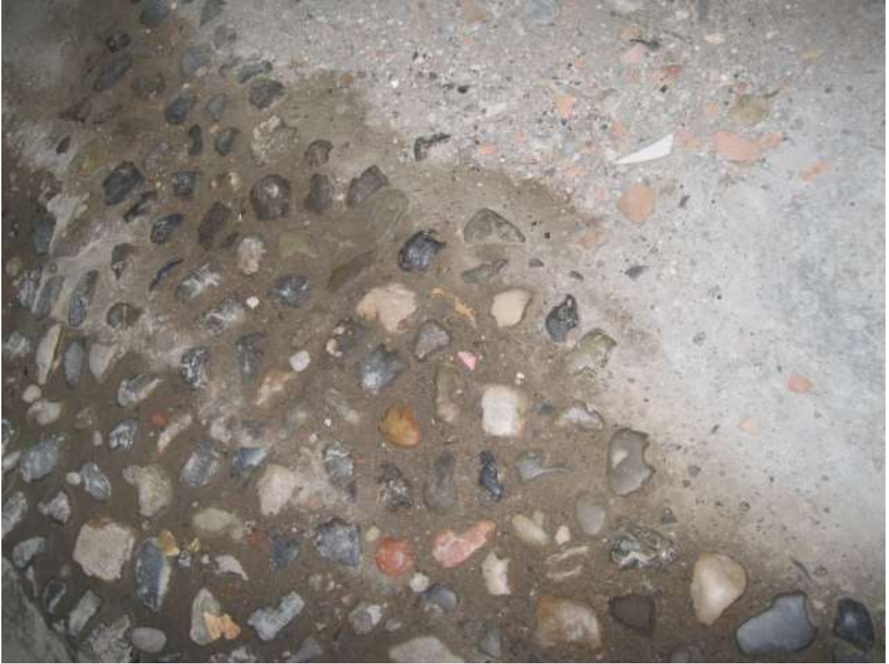
FOTO 9: particolare della rizzata alla lombarda (acciottolato) realizzato con ciottoli di fiume nell'ingresso comune di via Della Croce n. 11, di valore storico e culturale
