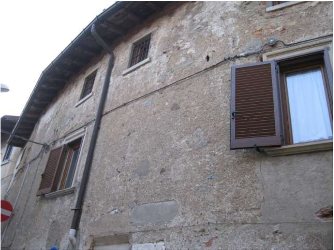
FOTO 3: particolare della copertura della casa con visuale su via Della Croce
