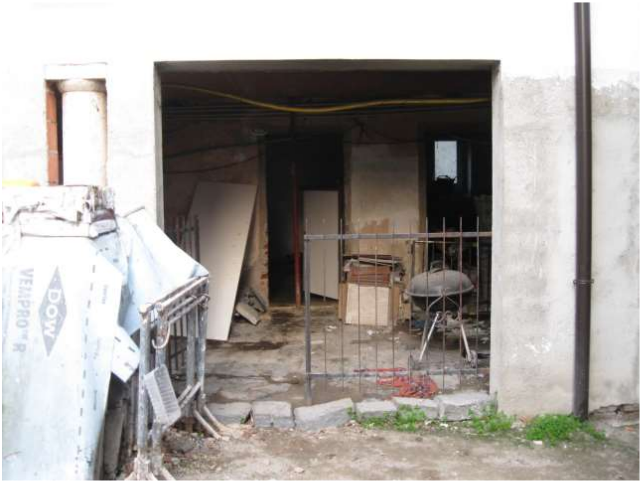
FOTO 7: il piano terreno della proprietà visto dal cortile ad oggi ancora allo stato rustico
