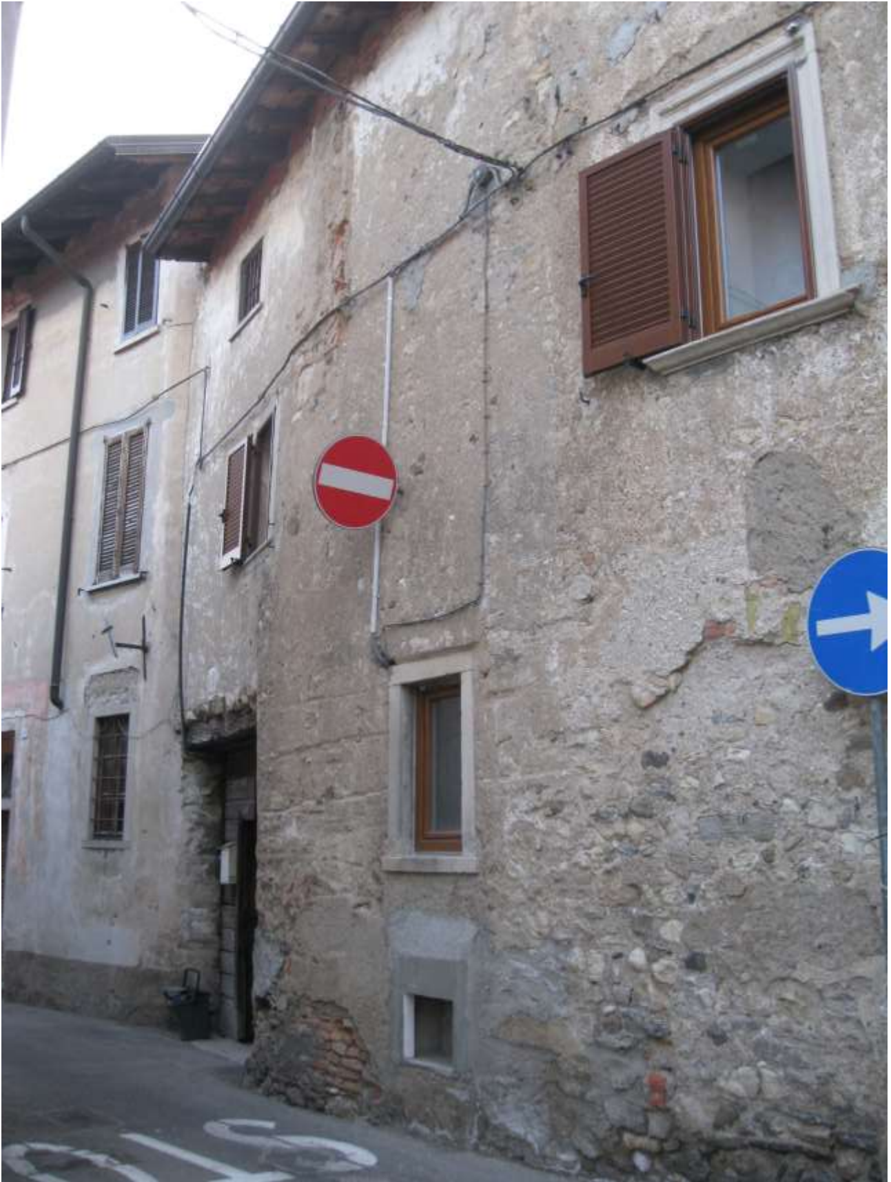
FOTO 2: la facciata della casa su via Della Croce n. 11
