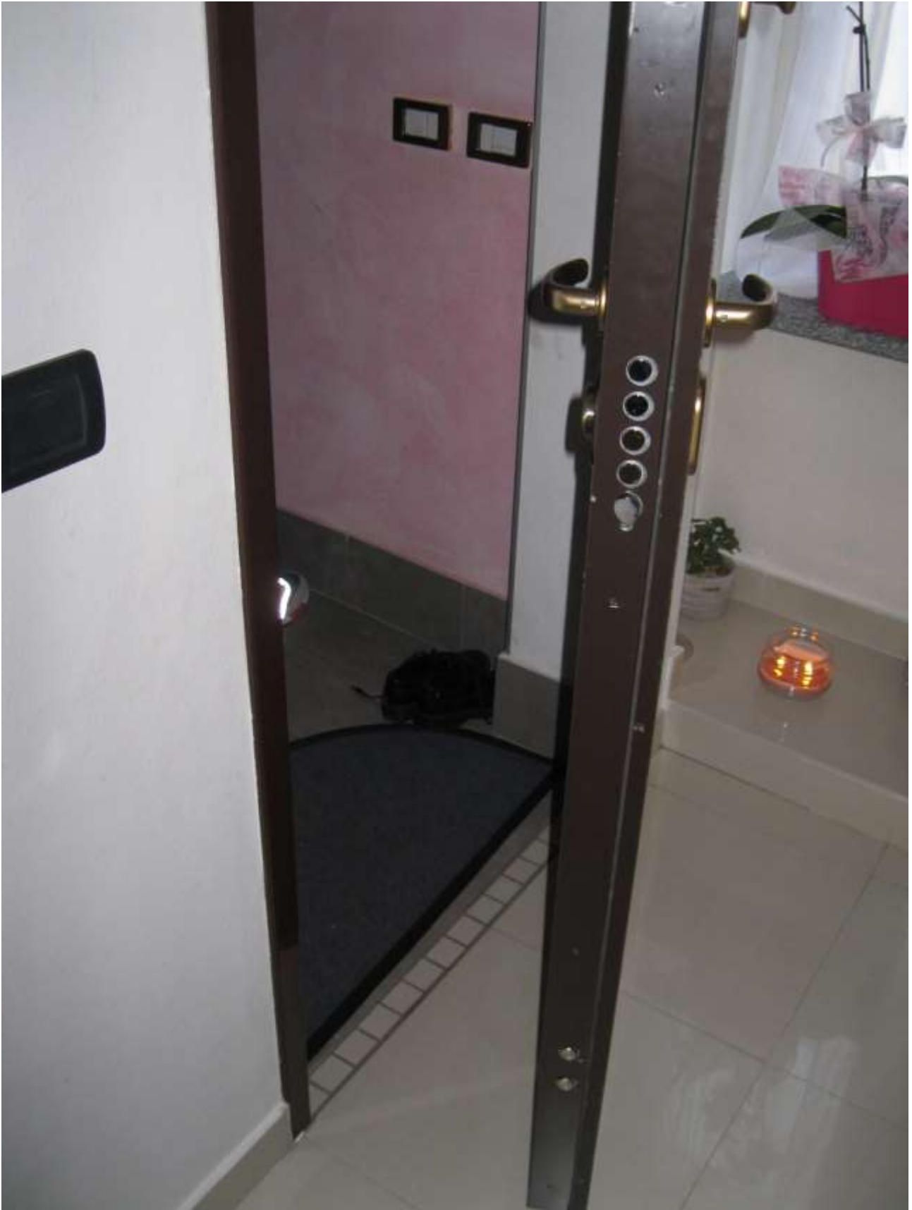
FOTO 12: particolare della porta blindata d'accesso all'appartamento realizzato al primo piano
