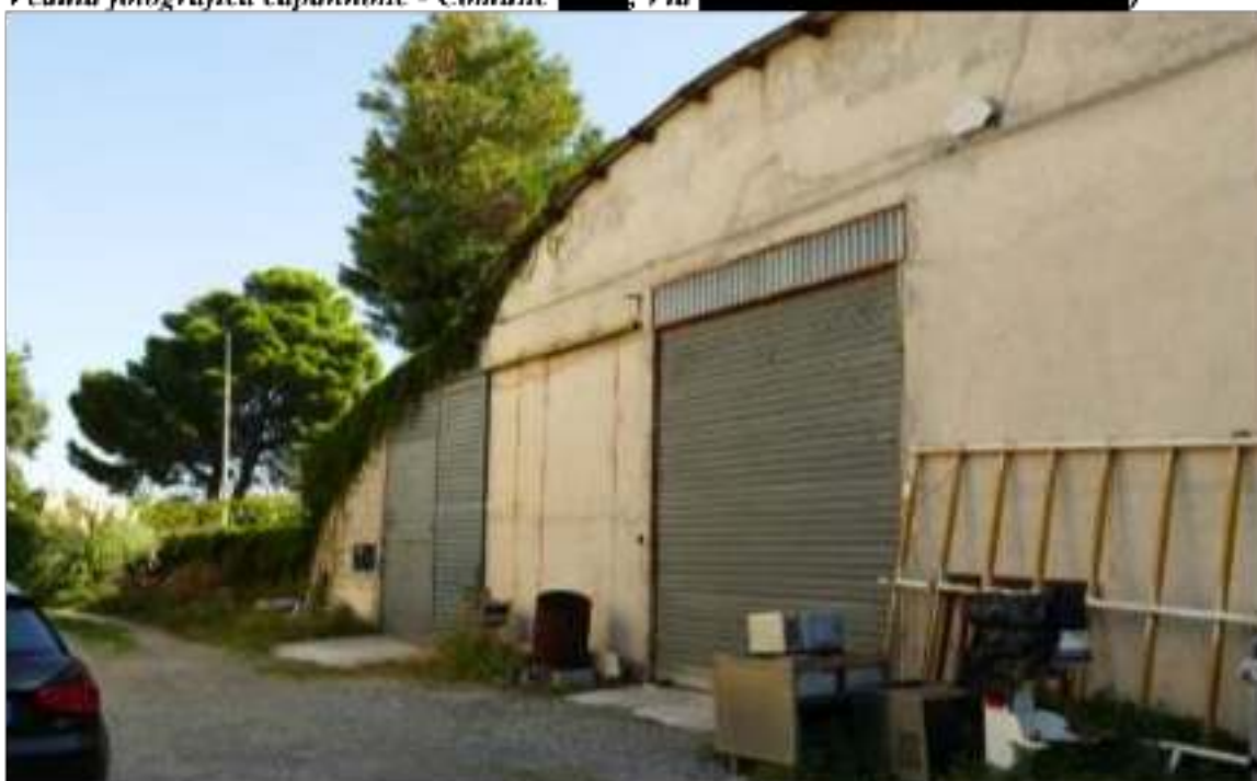
Veduta fotografica capannone - Comune [redacted] Via [redacted]
