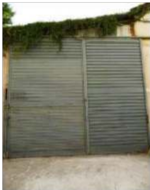
Part. fotografico corpo aggiunto al capannone
