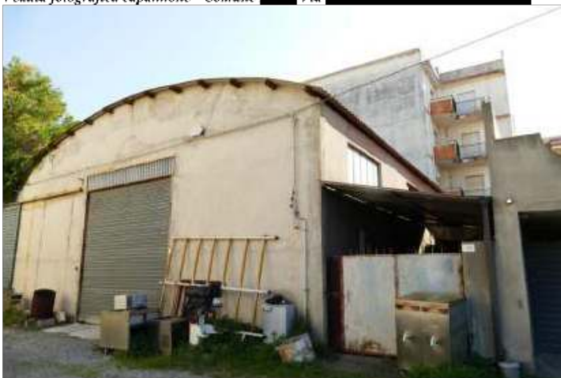
Veduta fotografica prospettica capannone - Comune [redacted] Via [redacted]
