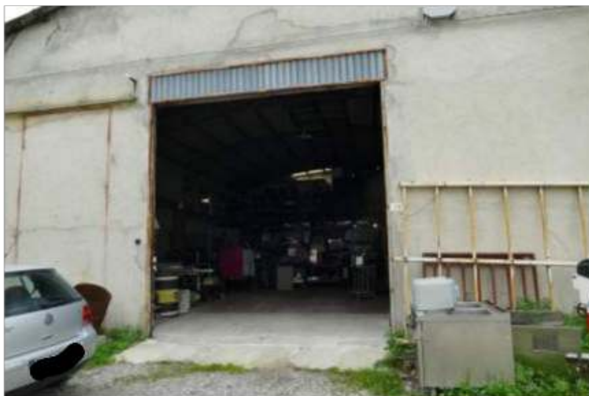
Veduta fotografica capannone - Comune [redacted], Via [redacted]
