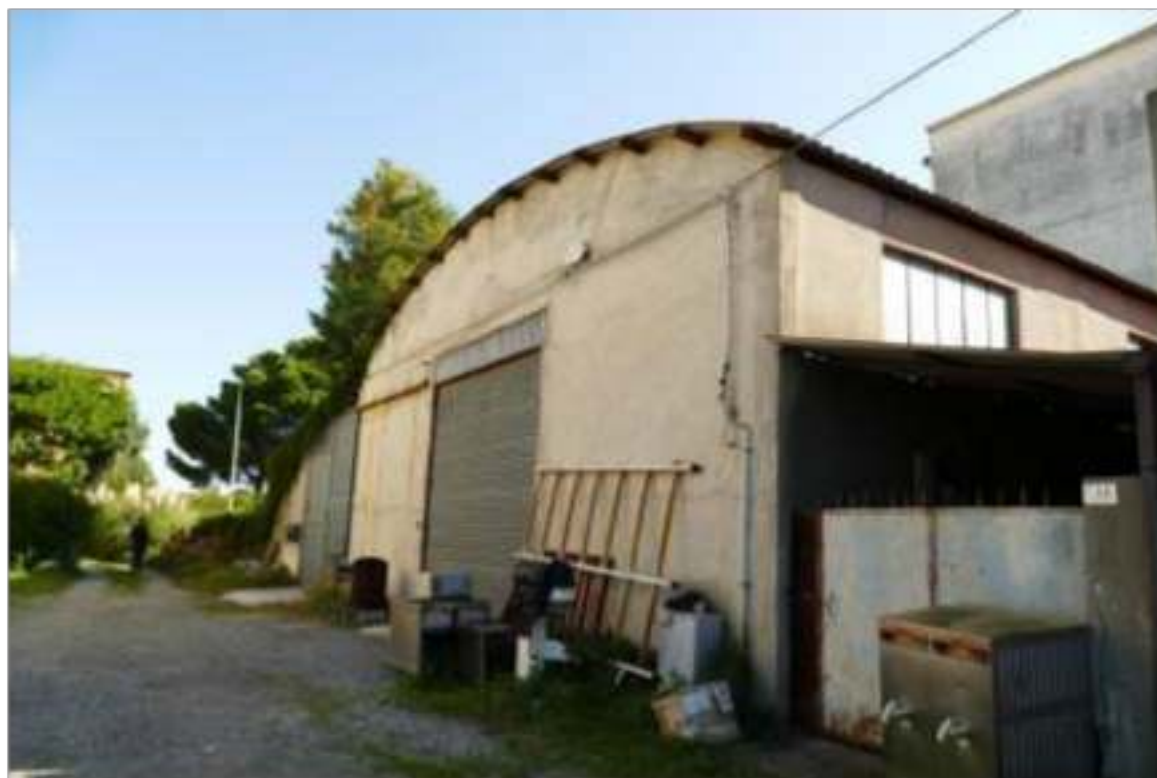
Veduta fotografica capannone - Comune [redacted] Via [redacted]
