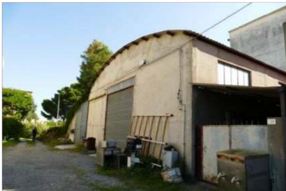
Particolare fotografico capannone industriale (settore falegnameria)
